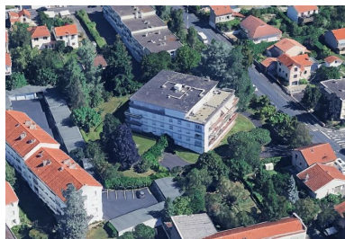
Vue aérienne de la résidence depuis le sud. Repro. Brigitte Ceroni, Autr. Google Earth IVR84_20256301560NUCA
