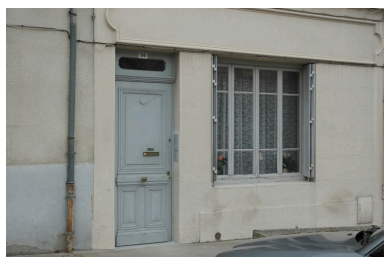
Vue du 1er niveau : ancienne boutique ? Phot. Simone Hartmann-Nussbaum IVR82_20114201230NUCA
