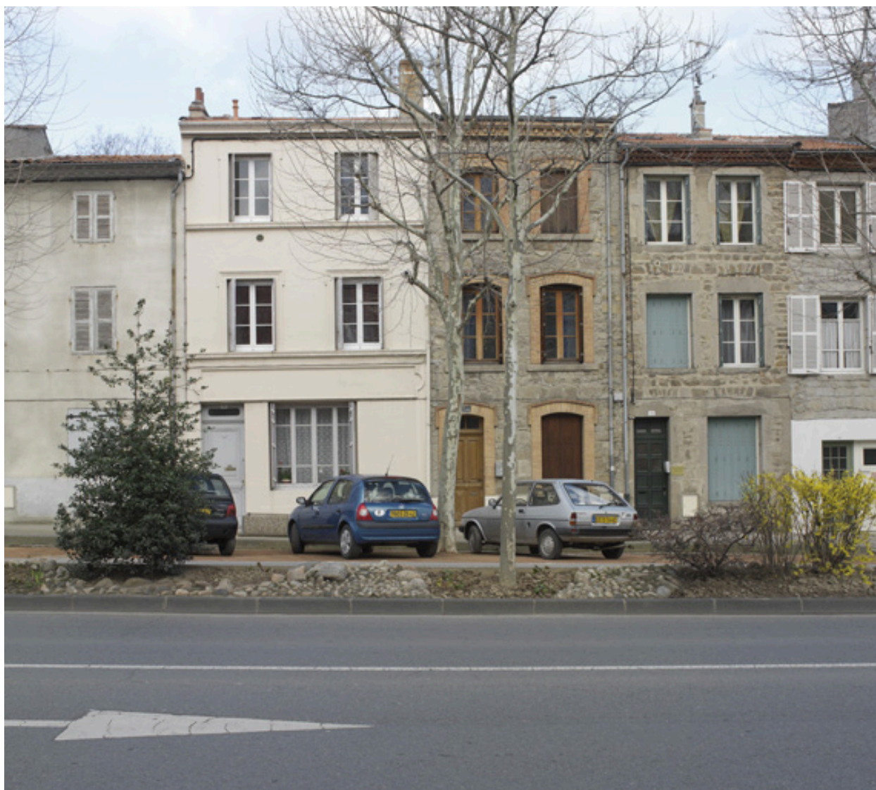
Vue générale (2e maison à partir de la gauche).
