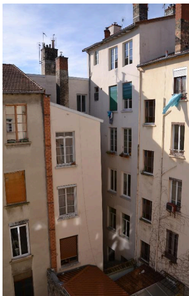
Vue générale façade arrière
