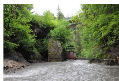
Vue amont de la prise d'eau. Phot. Clara Bérelle IVR84_20167306297NUCA
