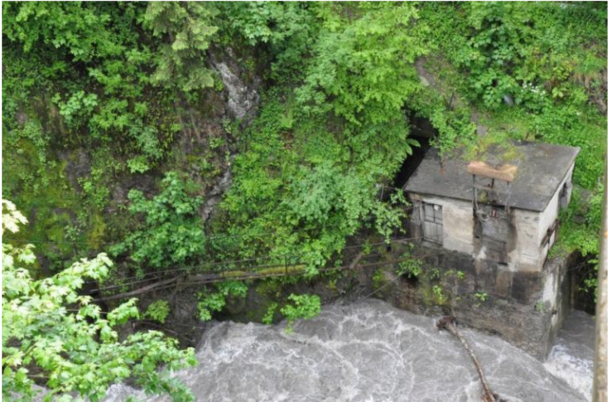
Vue de la centrale depuis le pont Morand.
