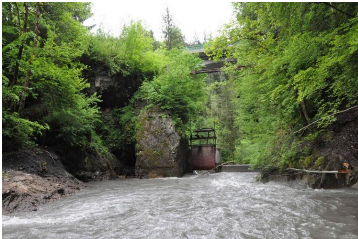
Vue amont de la prise d'eau.
