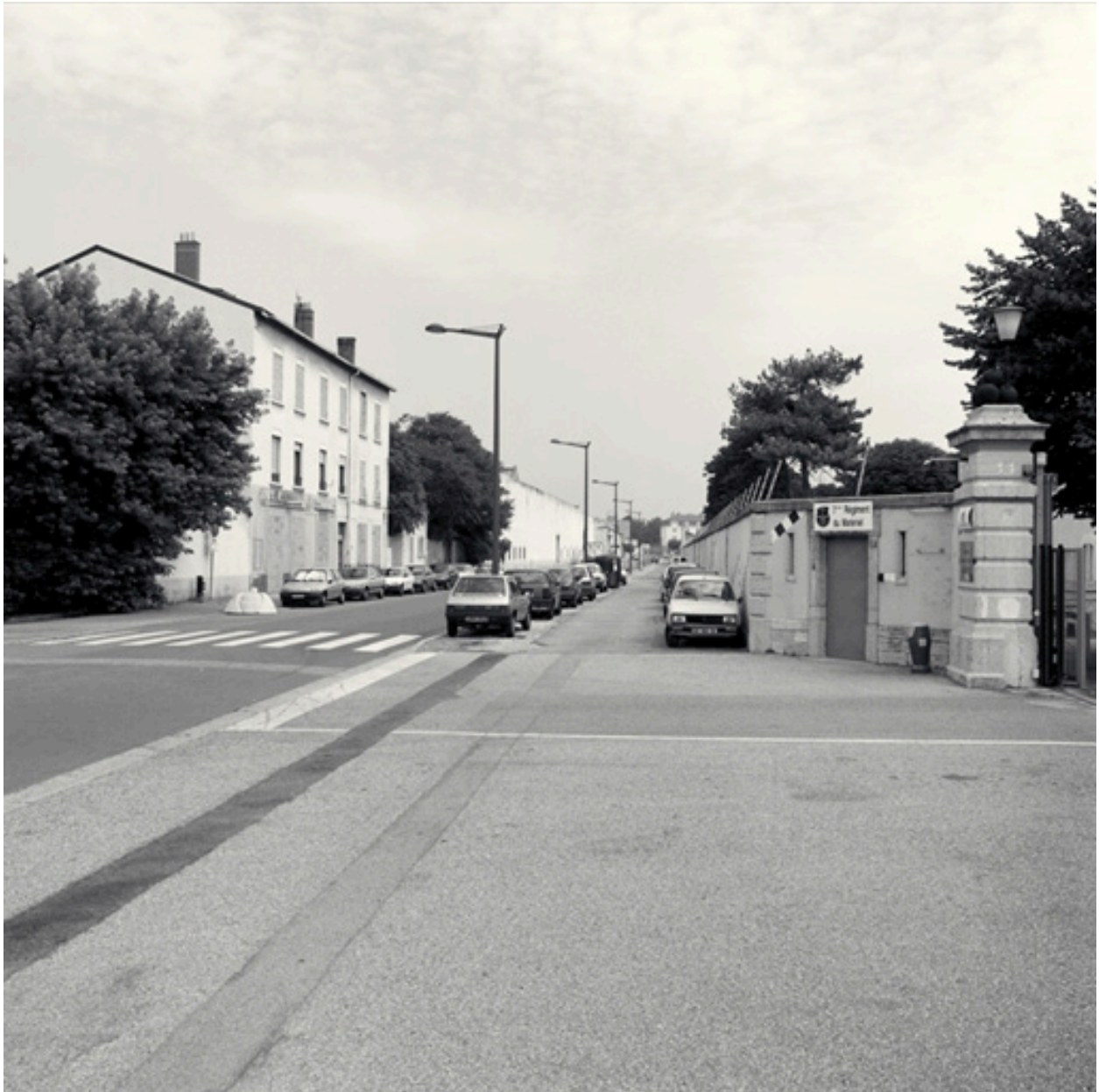
Ciapem nord-est, boulevard de l'Artillerie
