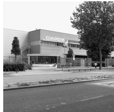
Nouvelle entrée, sud, rue Challemeil Lacour Phot. Martial Couderette IVR82_20016903059X
