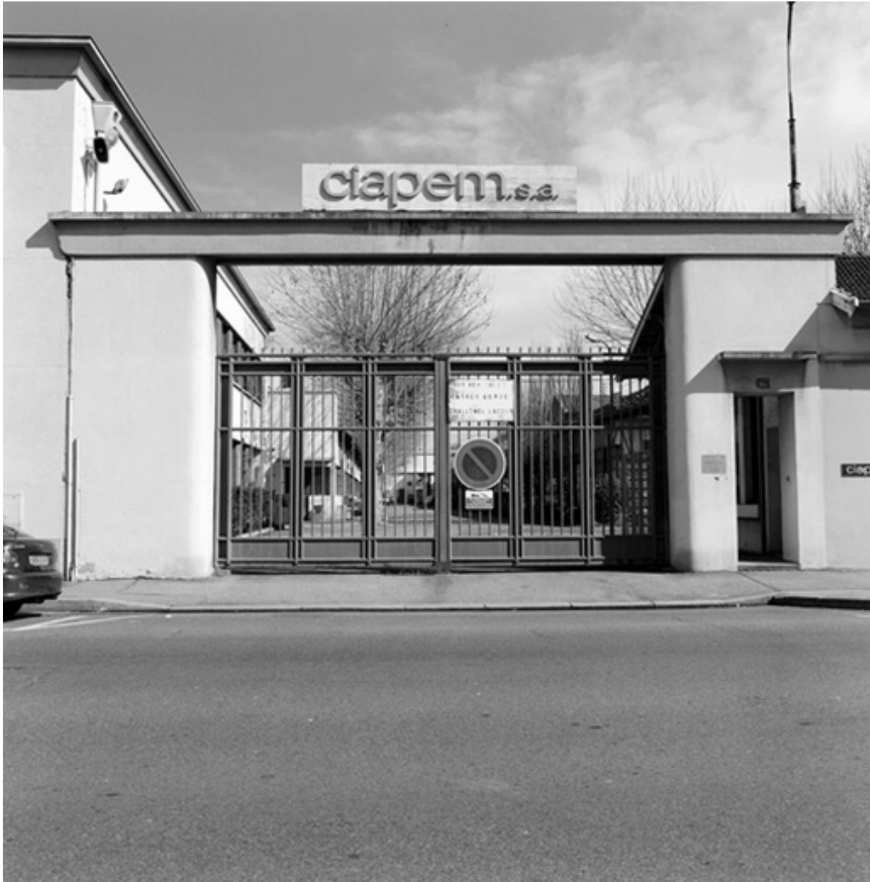
Vue d'ensemble sud-est
