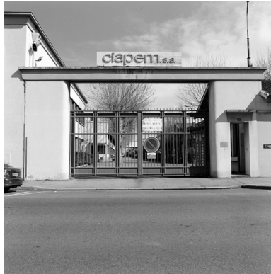
Vue d'ensemble sud-est Phot. Martial Couderette IVR82_20016903053X
