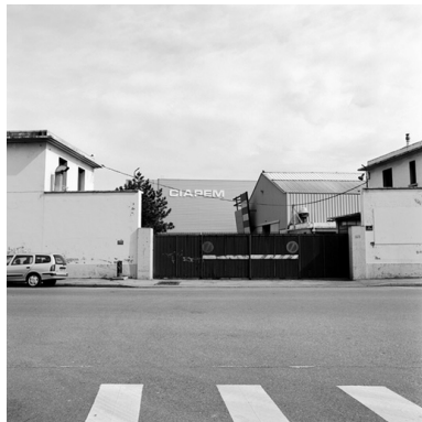
Entrée livraisons au 163 rue de Gerland, ancienne entrée de la société chimique de Gerland. Phot. Martial Couderette IVR82_20016903057X
