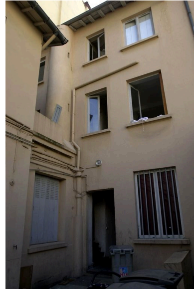
Elévation postérieure Phot. Maryannick Chalabi IVR82_20046904622NUCA
