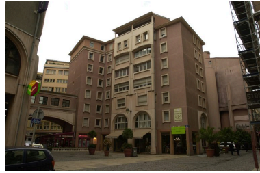
Vue générale depuis la rue Thomassin Phot. Véronique Belle IVR82_20076901250NUCA
