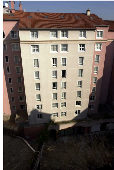
Elévation nord de la cour fermée Phot. Véronique Belle IVR82_20076902914NUCA
