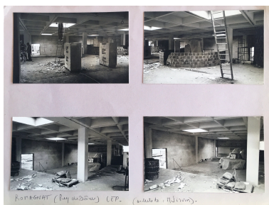
Le préau du centre socio culturel en cours de chantier ; sur les deux photos du bas, on voit la différence de niveau de sol où doit être installé l'ensemble sculpté (Phot. P. Sirvin ? ; AN, 19910237/12) Repro. Catherine Guégan, Autr. auteur inconnu IVR84_20236300104NUCA
