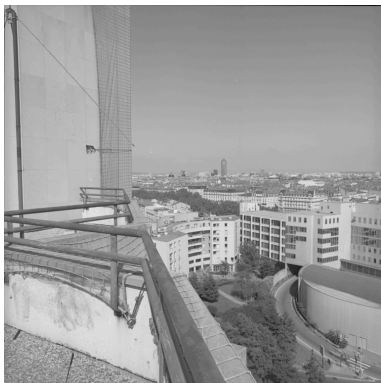
Vue générale depuis la tour du tunnel de Fourvière au sud
