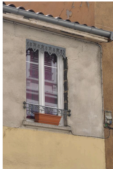
Vue rapprochée d'une fenêtre de l'étage Phot. Magali Delavenne IVR82_20156900960NUCA
