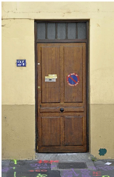
Vue rapprochée de la porte Phot. Magali Delavenne IVR82_20156900961NUCA
