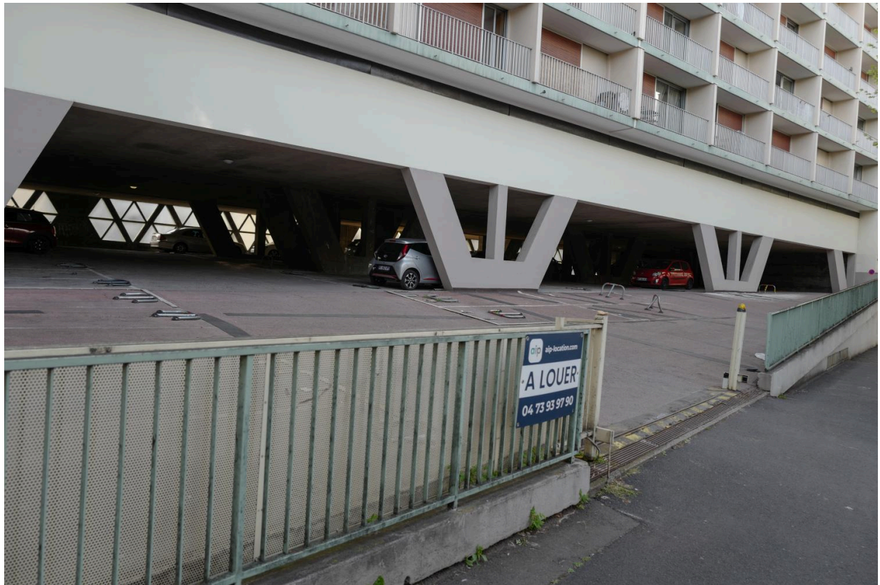
Rez-de-chaussée transparent sur pieux
