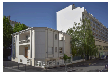
Elévation latérale sur la rue des Prés-Bas, façade sur le carrefour avec le boulevard Cote-Blatin Phot. Félicie Fougère IVR84_20246301293NUCA
