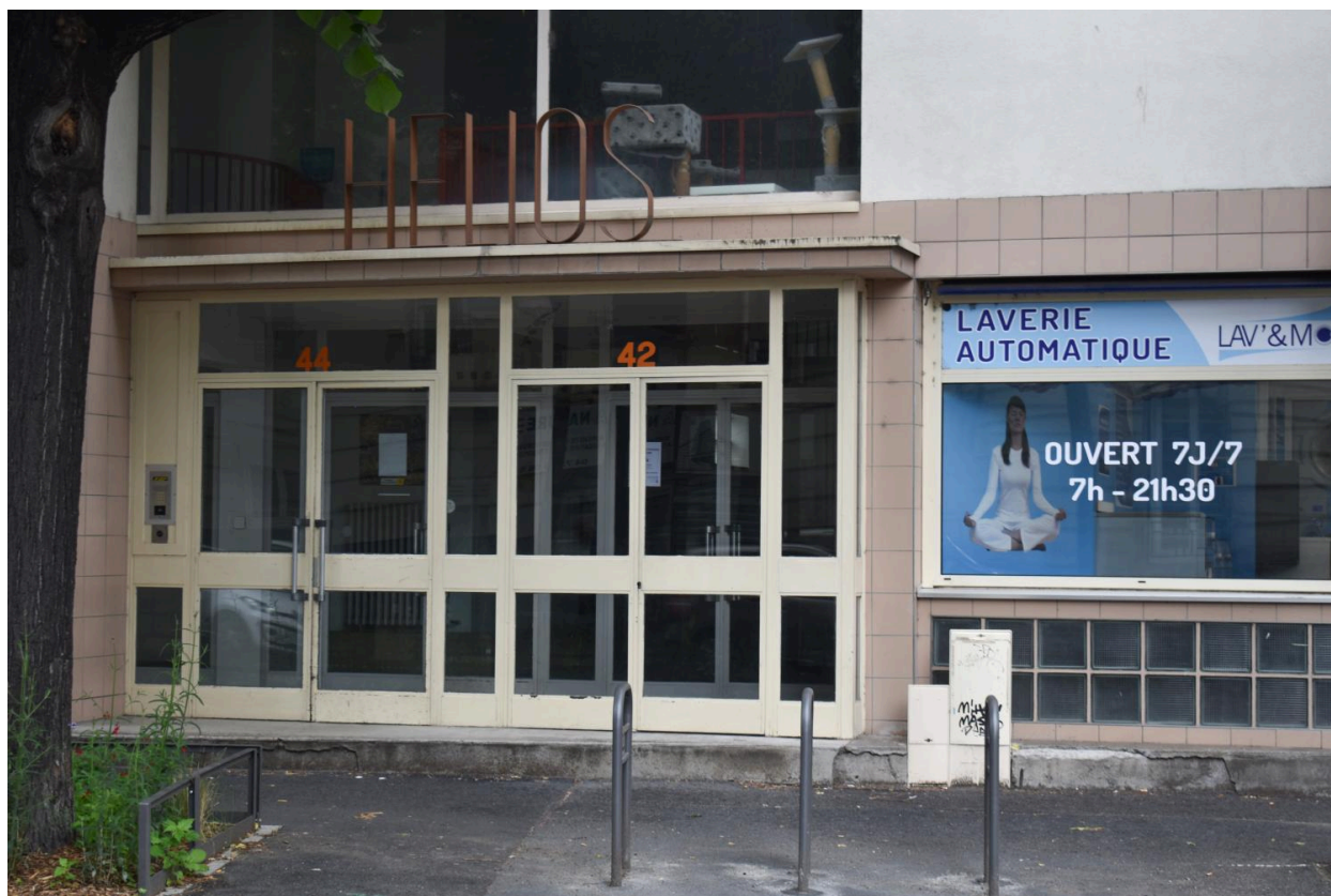
Portes bâtarde du hall d'entrée
