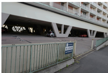
Rez-de-chaussée transparent sur pieux Phot. François-Nicolas L'Hardy IVR84_20246300984NUCA
