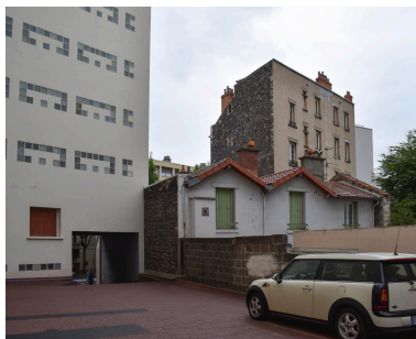
Elévation postérieure vue depuis l'entrée de parking du n°46 boulevard Cote-Blatin Phot. Félicie Fougère IVR84_20246301395NUCA
