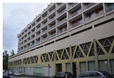
Elévation postérieure rue des Prés-Bas Phot. Félicie Fougère IVR84_20246301338NUCA
