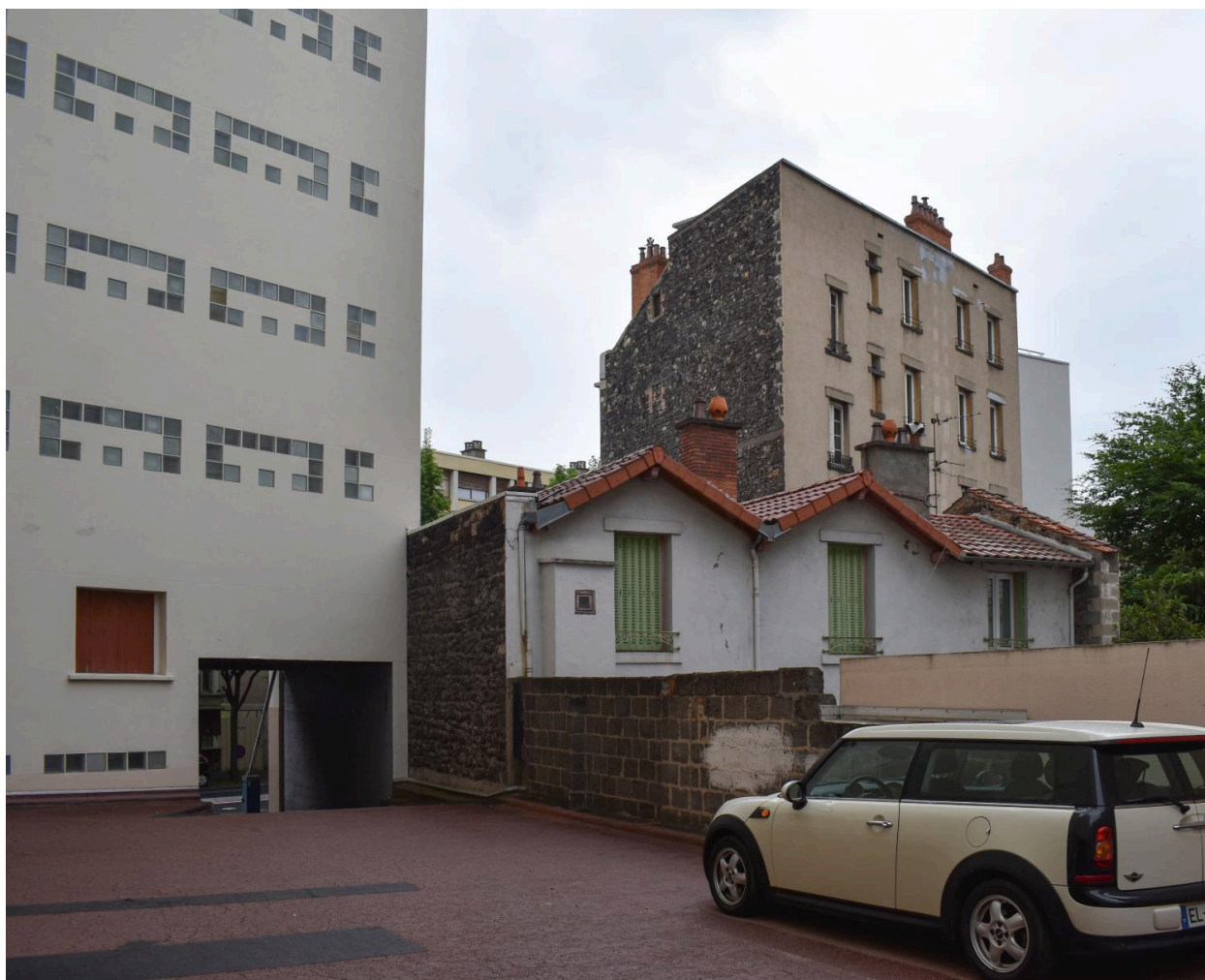
Élévation postérieure vue depuis l'entrée de parking du n°46 boulevard Cote-Blatin
