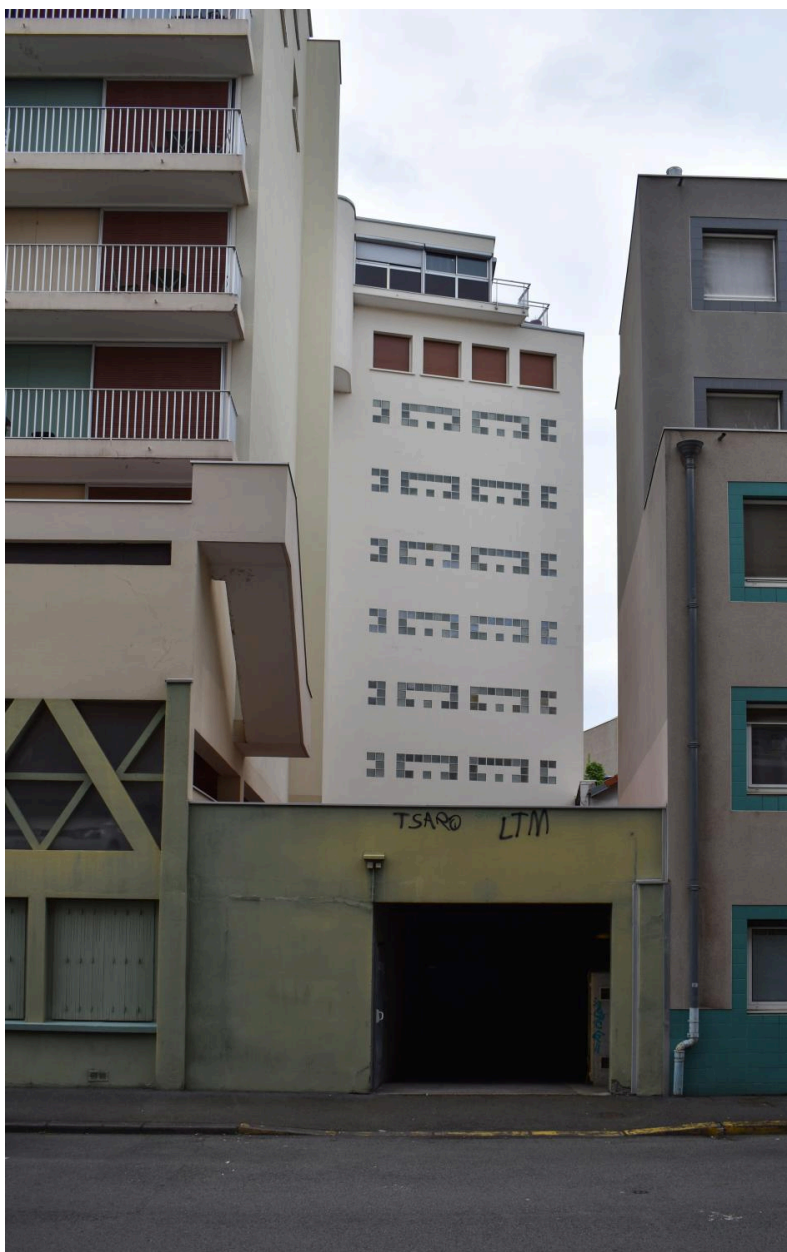
Elévation postérieure de l'extrémité sud, vue depuis la rue des Prés-Bas
