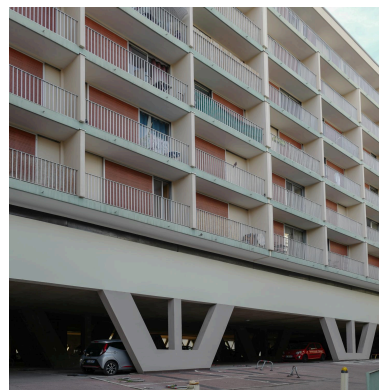
Façade épaisse, rez- de-chaussée sur pieux Phot. François-Nicolas L'Hardy IVR84_20246300985NUCA
