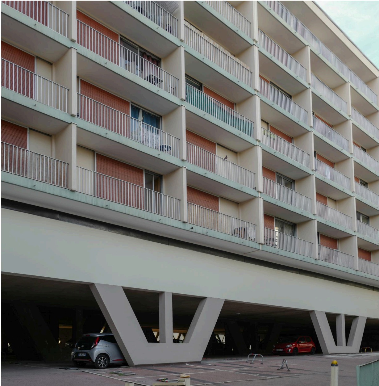
Façade épaisse, rez-de-chaussée sur pieux
