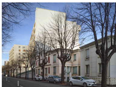
Vue urbaine, mur d'héberge Phot. Christian Parisey IVR84_20236300305NUC4A
