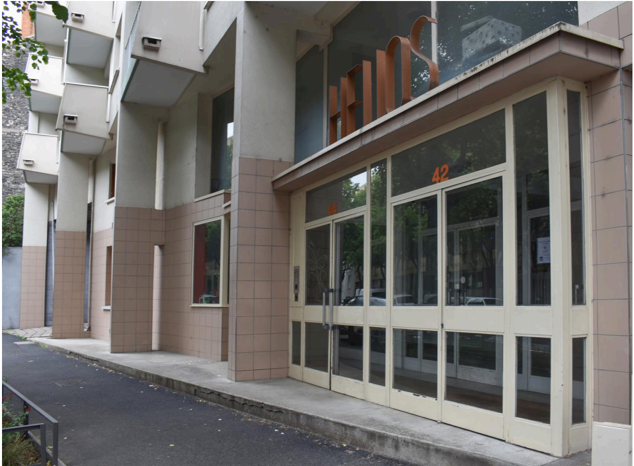
Rez-de-chaussée sur le boulevard, effet de redans
