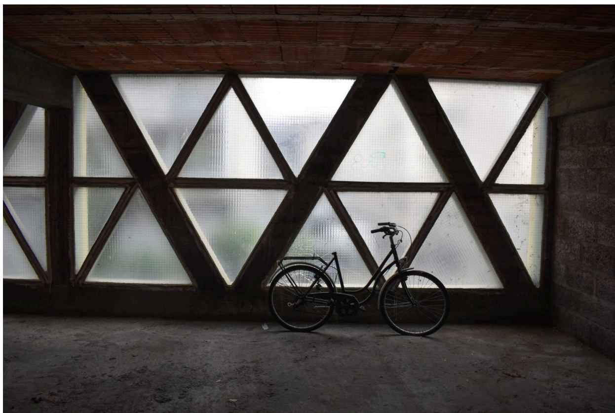
Détail de baies dans le garage surélevé
