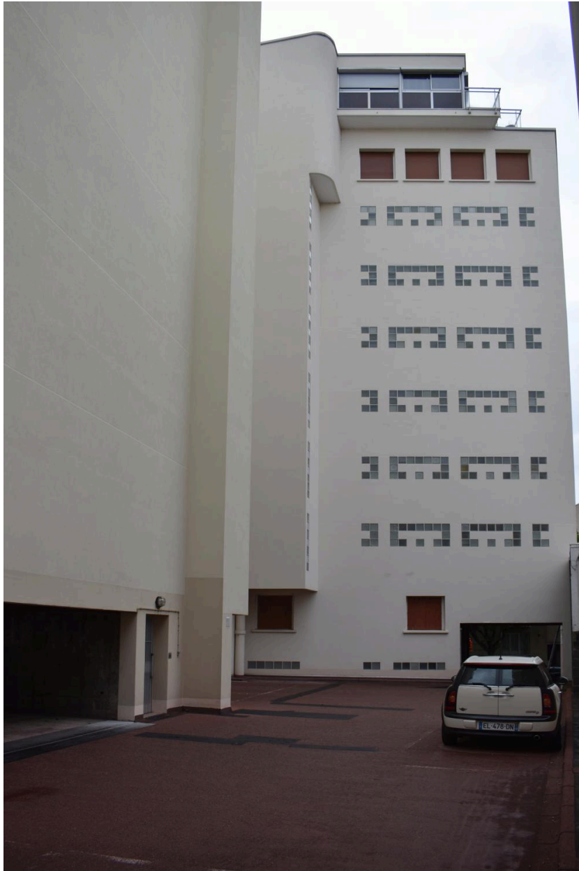
Elévation postérieur de l'extrémité sud, vue depuis la cour surélevée
