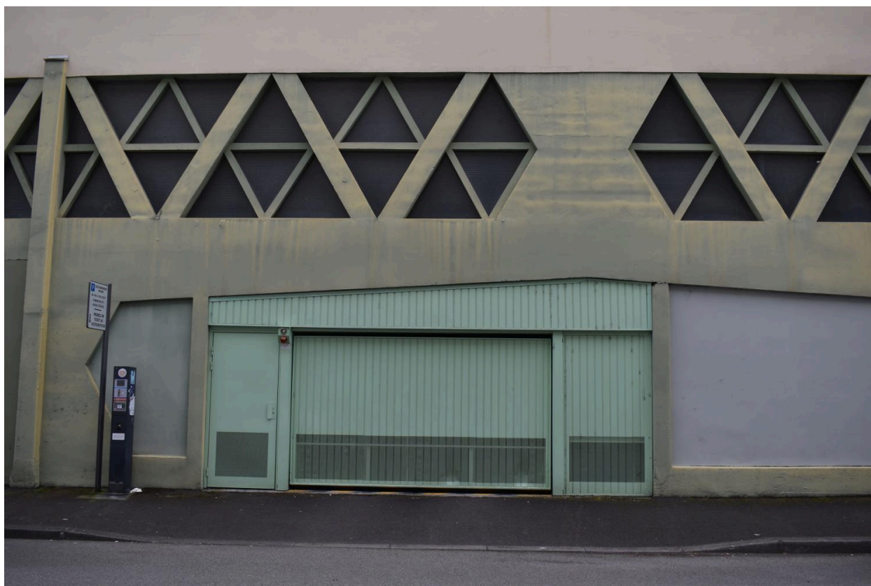
Porte de garage sur la rue des Prés-Bas, arrière du bâtiment
