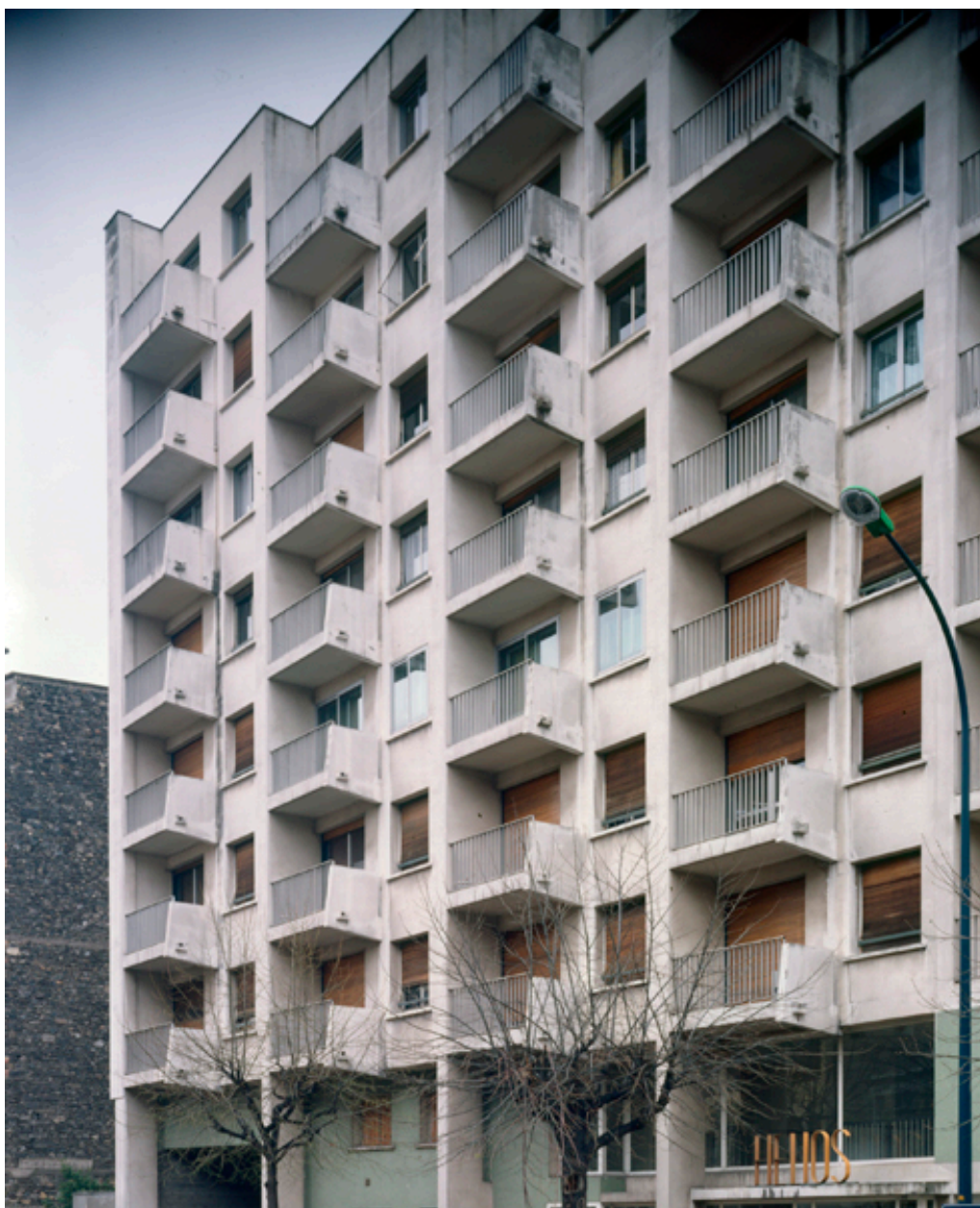
Détail de façade sur le boulevard Cote-Blatin
