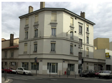
Vue générale depuis le sud-est Phot. Maryannick Chalabi IVR82_20076902077NUCA
