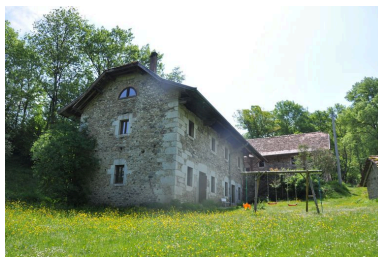
Elévation nord-ouest du moulin principal Phot. Samir Mahfoudi, Autr. Samir Mahfoudi IVR82_20107400589NUCA
