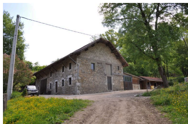
Mur pignon sud du premier moulin Phot. Samir Mahfoudi, Autr. Samir Mahfoudi IVR82_20107400591NUCA
