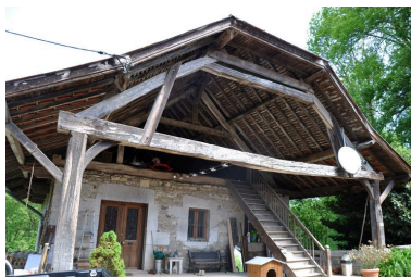
Fermes en bois du second bâtiment du moulin Phot. Samir Mahfoudi, Autr. Samir Mahfoudi IVR82_20107400592NUCA
