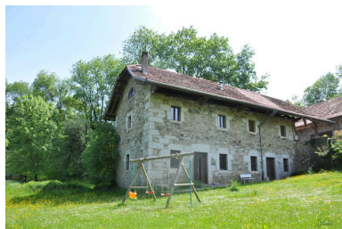
Façade antérieure du moulin principale Phot. Samir Mahfoudi, Autr. Samir Mahfoudi IVR82_20107400588NUCA
