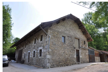
Elévation nord-est du bâtiment secondaire Phot. Samir Mahfoudi, Autr. Samir Mahfoudi IVR82_20107400584NUCA
