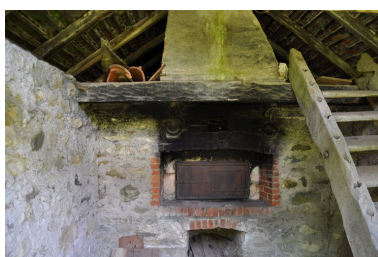
Vue intérieure du four à pain Phot. Samir Mahfoudi, Autr. Samir Mahfoudi IVR82_20107400586NUCA
