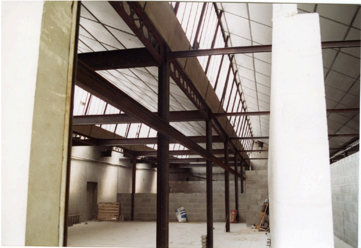
Réhabilitation du site : travaux en 1994. Ecole Emile Cohl Archives privées. Ecole Emile Cohl
