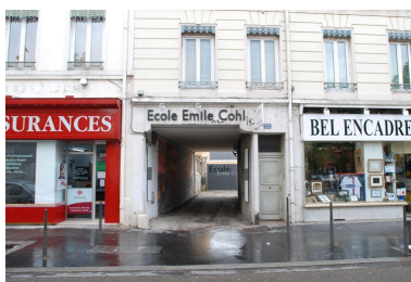
Porche de l'entrée principale rue Paul Bert Phot. Nadine Halitim-Dubois IVR82_20096901581NUCA
