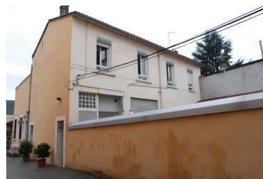
Vue nord-est Phot. Nadine Halitim-Dubois IVR82_20096901573NUCA
