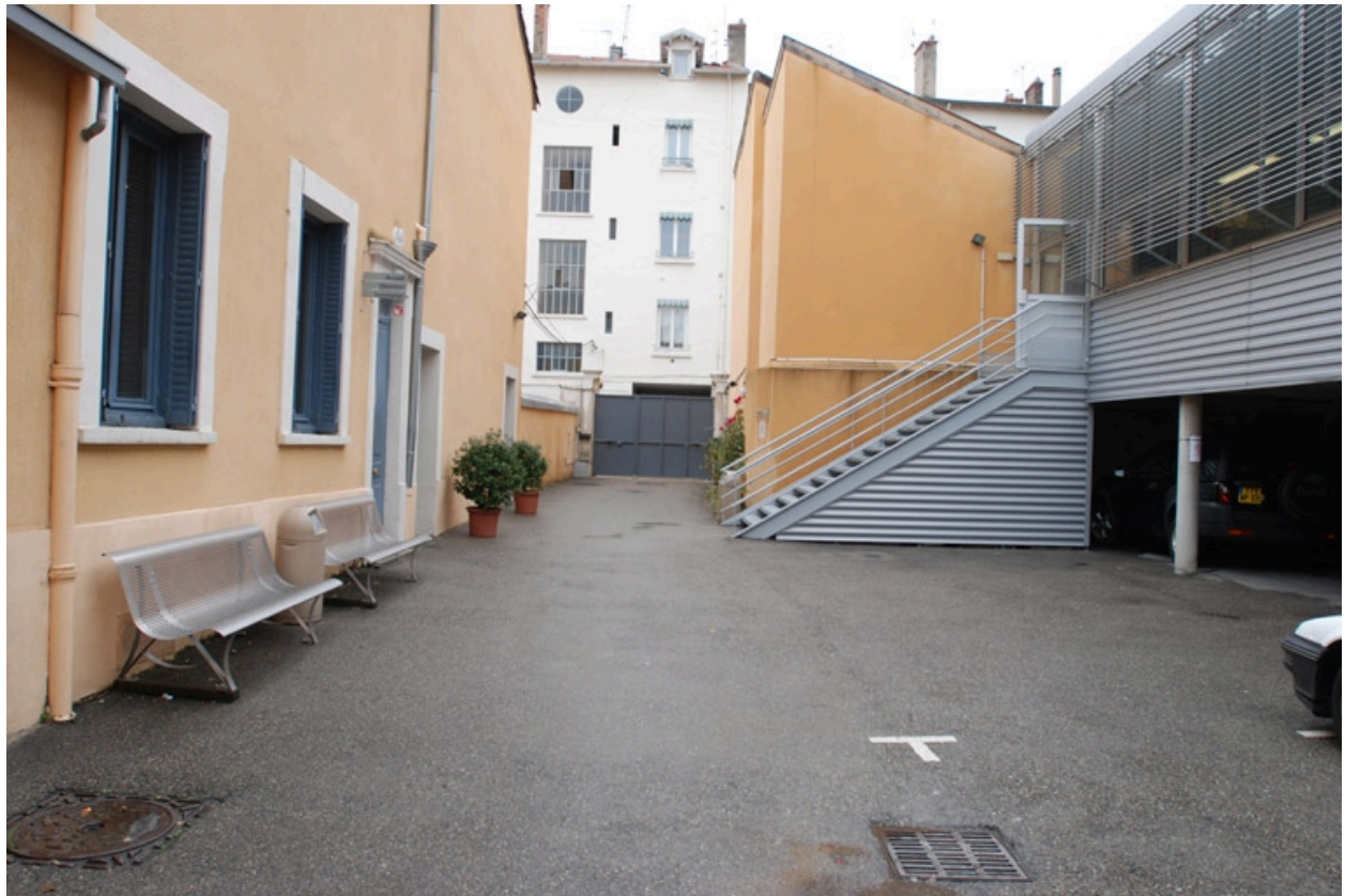
Vue d'ensemble sud
