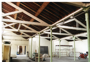
Chantier en 1994 : réhabilitation du site. Ecole Emile Cohl Archives privées. Ecole Emile Cohl Repro. Nadine Halitim-Dubois IVR82_20096901553NUCAB
