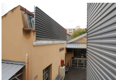
Aménagement des sheds Phot. Nadine Halitim-Dubois IVR82_20096901569NUCA
