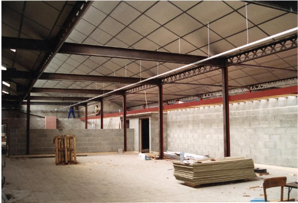
Travaux en 1994 : réhabilitation. Ecole Emile Cohl Archives privées. Ecole Emile Cohl
