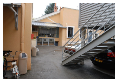
Vue extérieure nord Phot. Nadine Halitim-Dubois IVR82_20096901570NUCA
