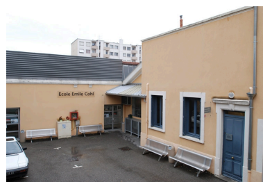
Vue nord-est Phot. Nadine Halitim-Dubois IVR82_20096901576NUCA
