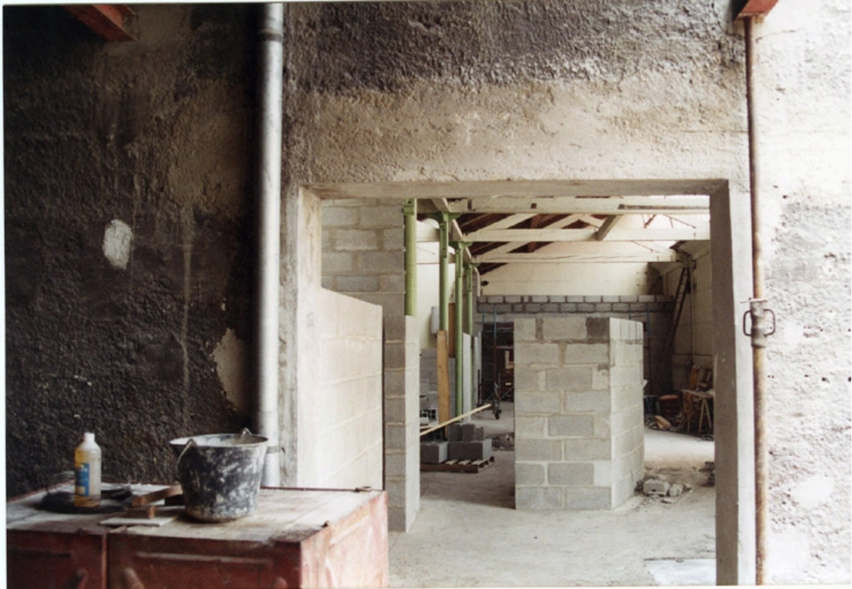
Etat au moment des travaux en 1994. Ecole Emile Cohl Archives privées. Ecole Emile Cohl
