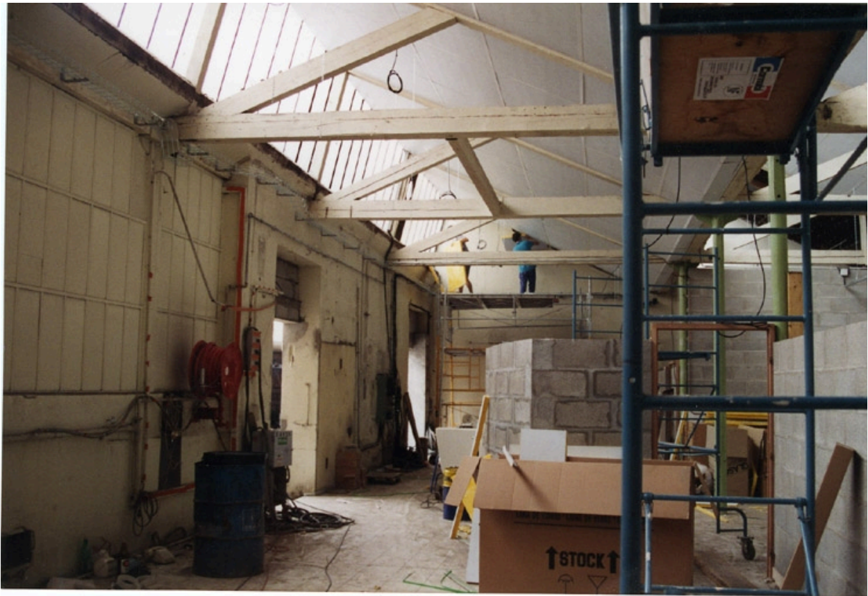
Etat au moment de la réhabilitation en 1994 : charpente en bois. Ecole Emile Cohl Archives privées. Ecole Emile Cohl
