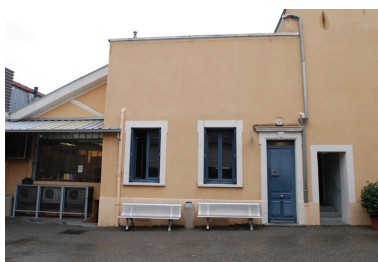
Vue est : partie administrative Phot. Nadine Halitim-Dubois IVR82_20096901575NUCA
