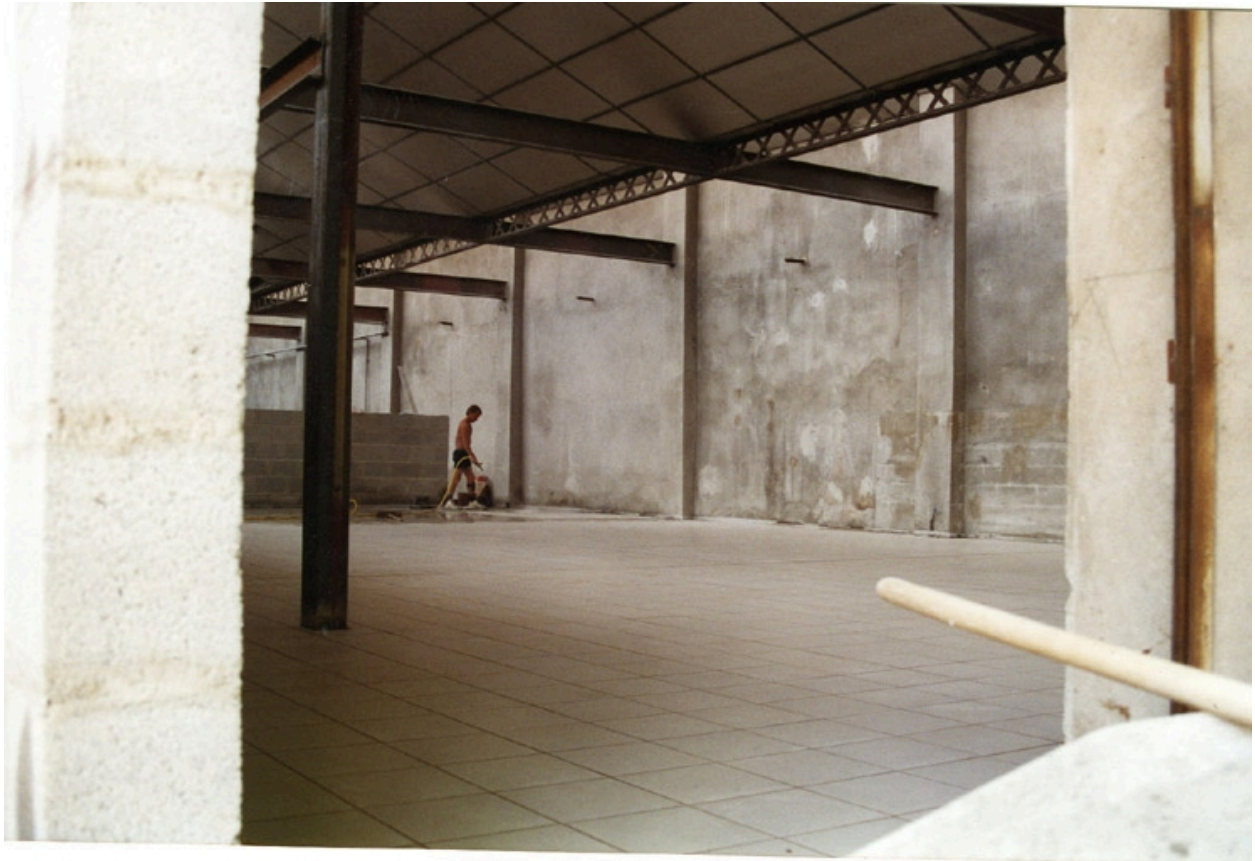
Chantier : réhabilitation en 1994. Ecole Emile Cohl Archives privées. Ecole Emile Cohl
