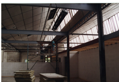
Travaux de réhabilitation du site en 1994. Ecole Emile Cohl Archives privées. Ecole Emile Cohl Repro. Nadine Halitim-Dubois IVR82_20096901556NUCAB
