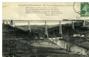
Le viaduc de Ribeyrès vers 1922, dans son état originel. Avant de voir ses piles partiellement immergées par les eaux du barrage en 1945, ce viaduc a été décrit, dès 1881, comme "un remarquable viaduc en tôle [sic] de cinq travées, précédées et suivies de trois arches en pierre [qui] franchit la Cère, qui coule au fond d'un étroit ravin".
