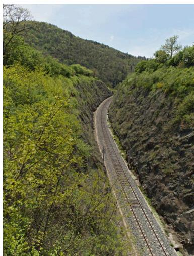
Site de la tranchée d'Aubeyrat. Avec 685 m de long, cette tranchée, l'une des plus longues de France, fait partie des travaux d'ingénieurs réalisés dans la vallée de l'Alagnon pour le passage du chemin de fer (voir aussi illustration suivante).
