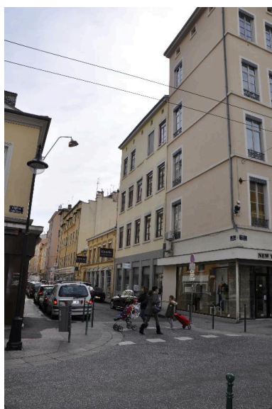
Vue d'ensemble nord ouest de l'immeuble de trois étages Phot. Nadine Halitim-Dubois IVR82_20146900386NUCA
