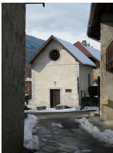
Vue de la façade principale depuis la rue. Phot. Jérôme Daviet IVR82_20107400803NUCA
