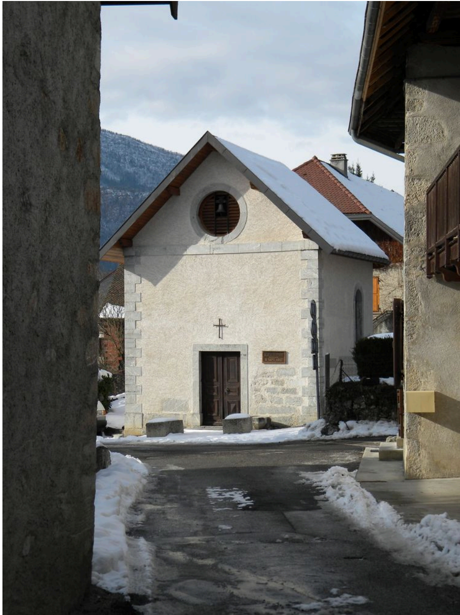
Vue de la façade principale depuis la rue.
