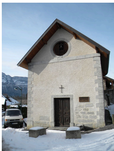
Vue générale de la façade principale. Phot. Jérôme Daviet IVR82_20107400806NUCA
