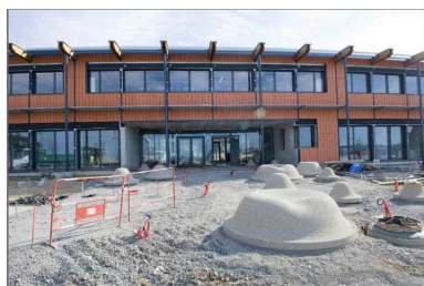
Œuvre en cours d'installation, devant le lycée. Autr. auteur inconnu IVR84_20204200102NUCAB
