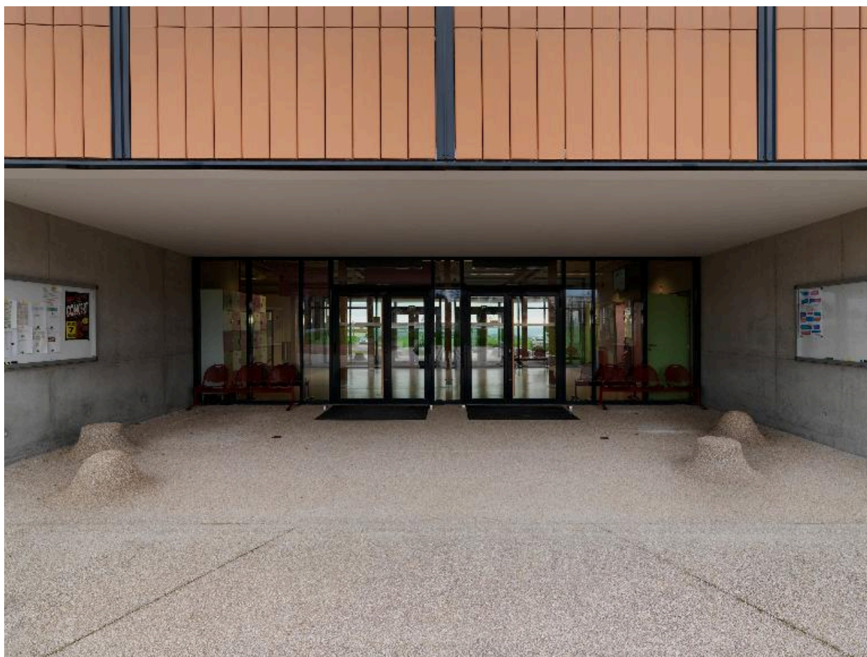
Vue de la partie sur cour, en 2015
