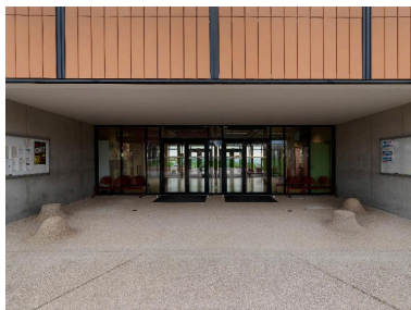
Vue de la partie sur cour, en 2015 Phot. Eric Dessert IVR82_20154200725NUCA
