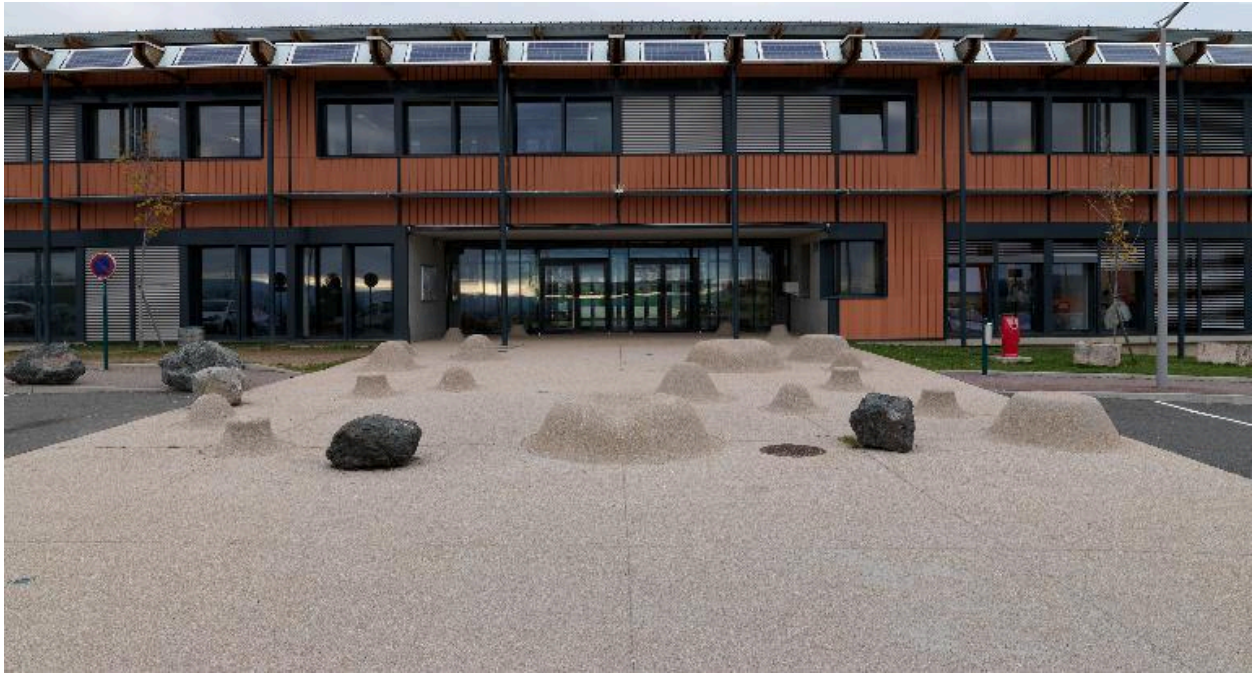
Vue d'ensemble de la partie extérieure, en 2015
