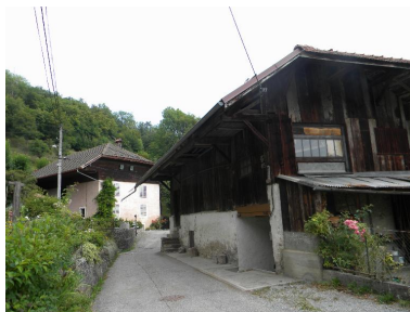
Vue de trois-quarts. Phot. Jérôme Daviet IVR82_20137401802NUCA
