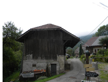
Vue du pignon sud. Phot. Jérôme Daviet IVR82_20137401199NUCA
