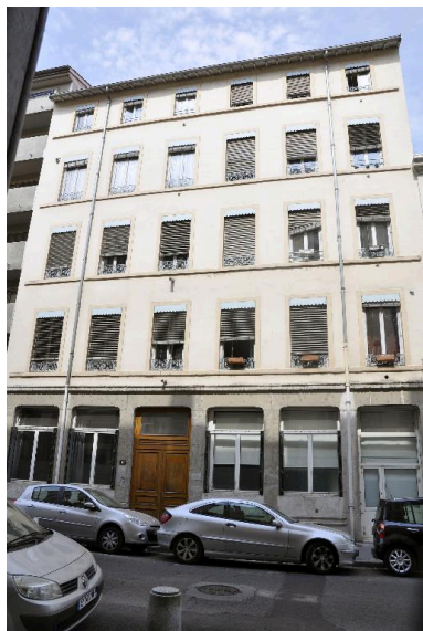
Vue générale de l'élévation sur rue Phot. Magali Delavenne IVR82_20146902691NUCA
