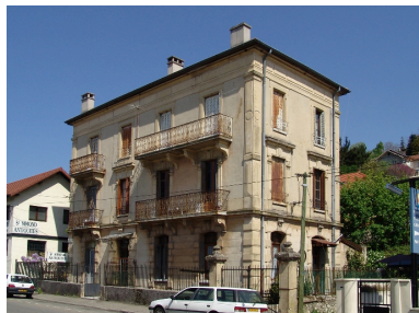
Vue générale depuis la rue Phot. François Fouger IVR82_20077300327NUCA
