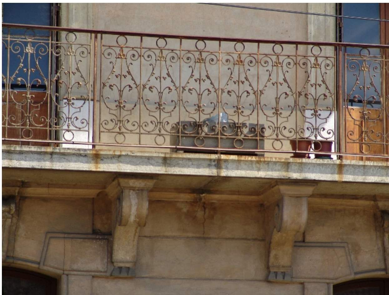
Détail d'un balcon du 1er étage
