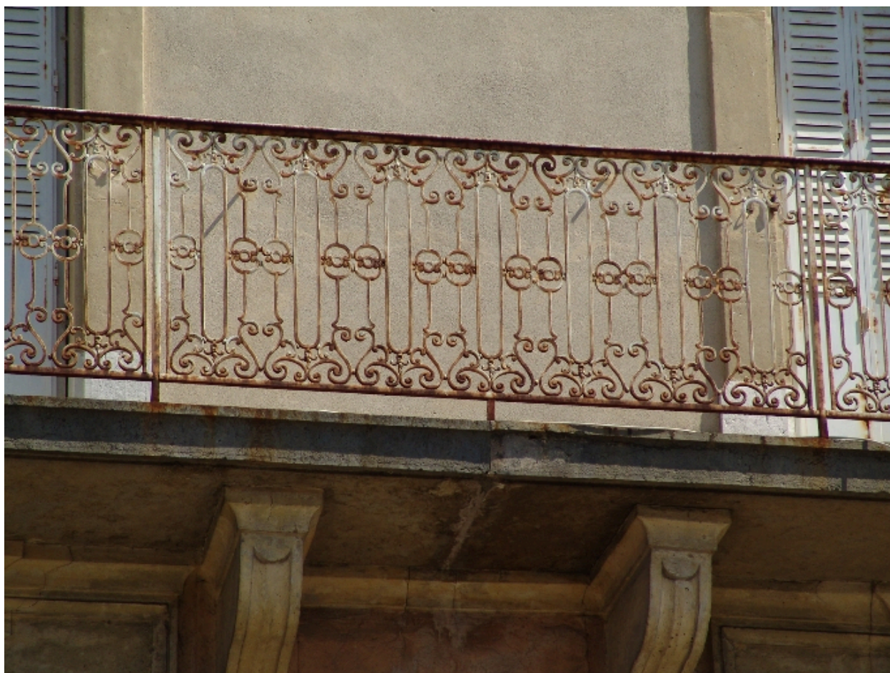
Détail d'un balcon du 2e étage
