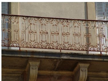
Détail d'un balcon du 2e étage Phot. François Fouger IVR82_20077300329NUCA
