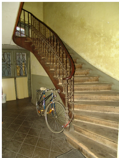
Escalier intérieur Phot. François Fouger IVR82_20077300333NUCA
