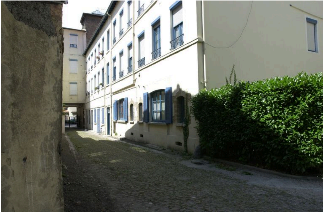
Passage couvert et tour d'escalier
