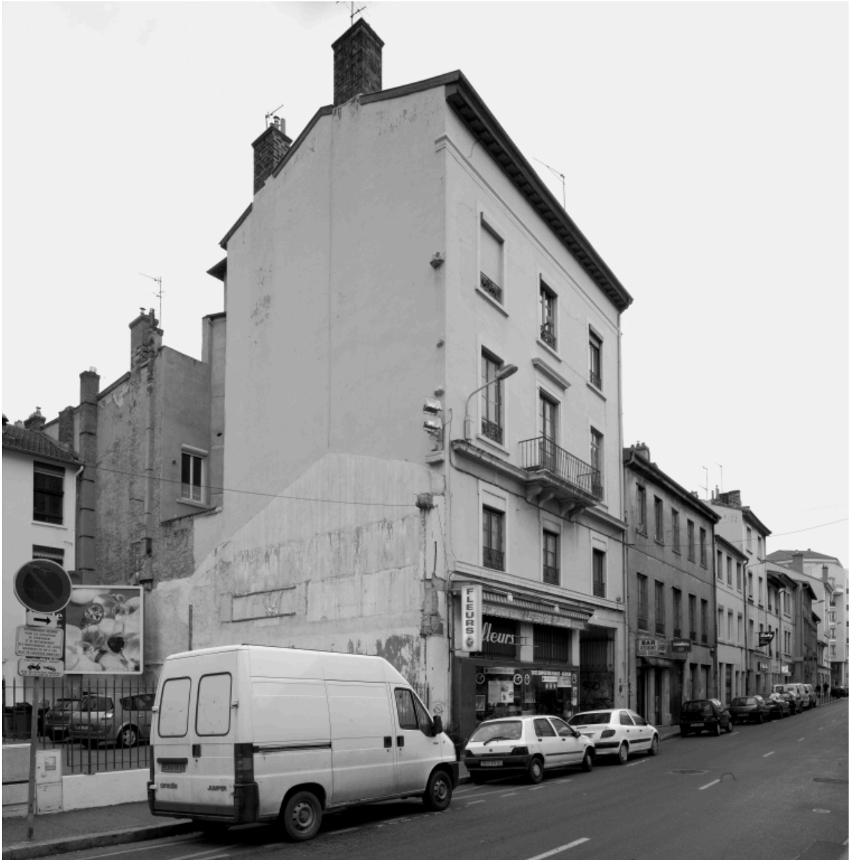
Vue générale depuis le sud-ouest
