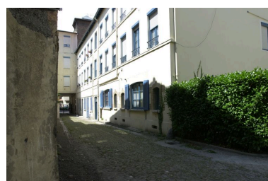
Passage couvert et tour d'escalier Phot. Maryannick Chalabi IVR82_20106903653NUCA
