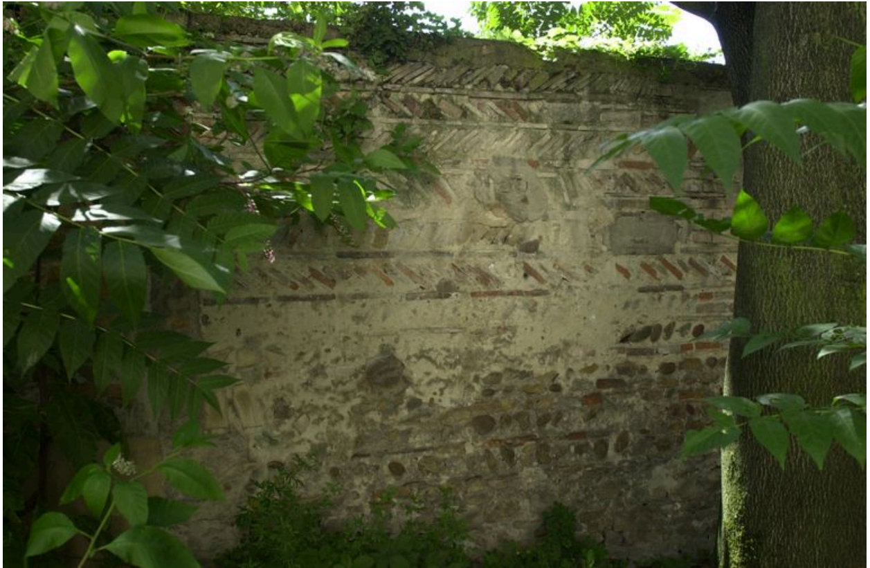
Mur de clôture : appareil en arêtes de poisson
