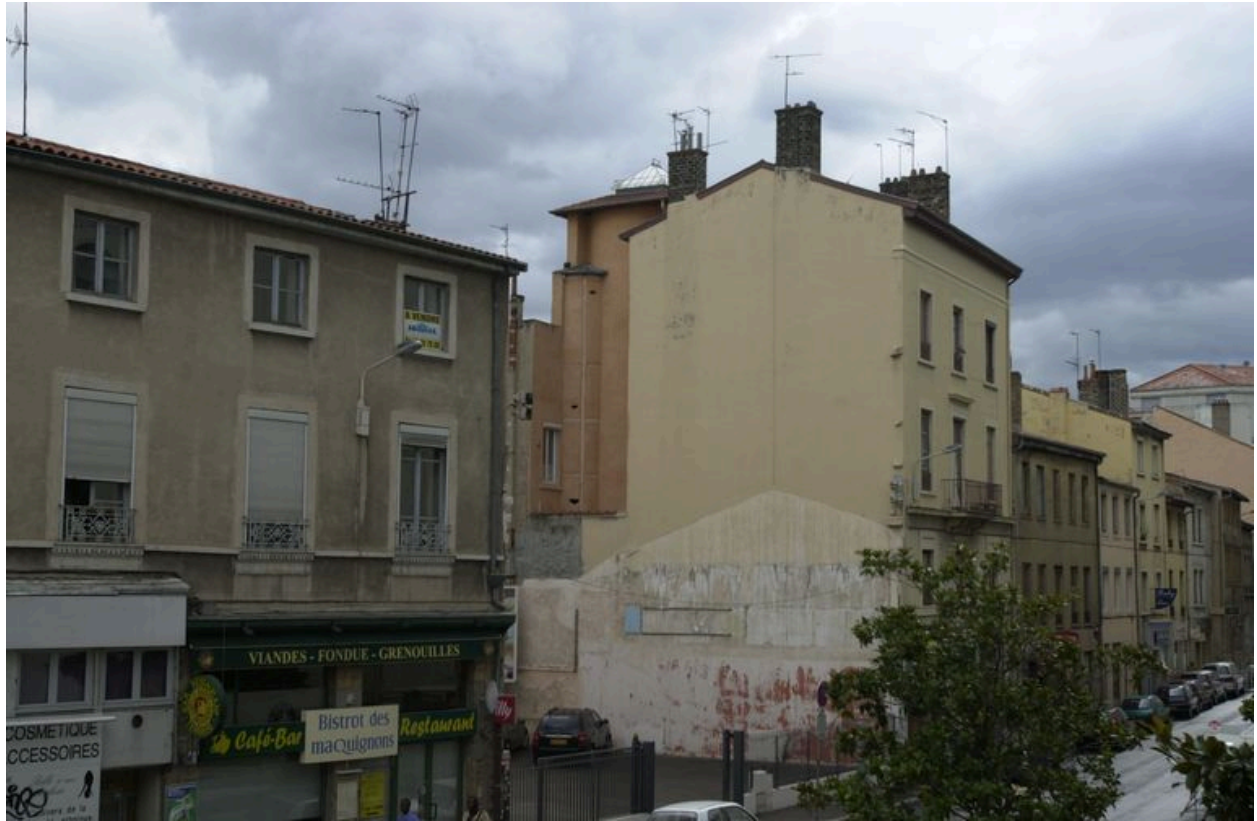
Vue générale depuis le sud-ouest
