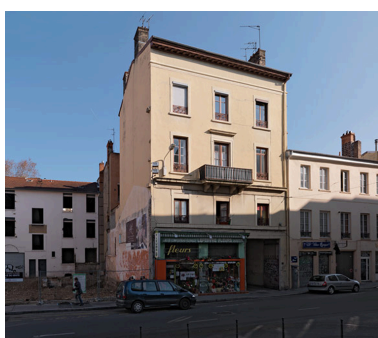
Élévation antérieure Phot. Eric Dessert IVR82_20126901373NUCA
