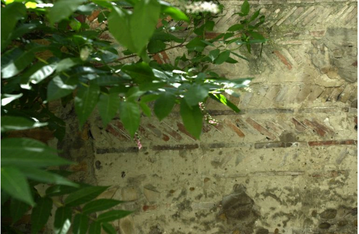
Détail de l'appareil en arêtes de poisson
