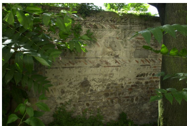
Mur de clôture : appareil en arêtes de poisson Phot. Maryannick Chalabi IVR82_20106903665NUCA
