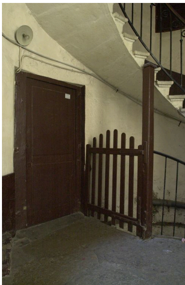
Entrée de cave sous l'escalier Phot. Maryannick Chalabi IVR82_20106903655NUCA
