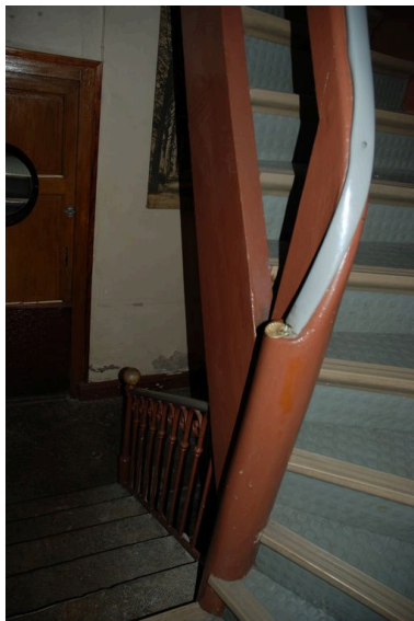
Vue prise du palier du premier étage. Phot. Catherine Guillot IVR82_20116903094NUCA
