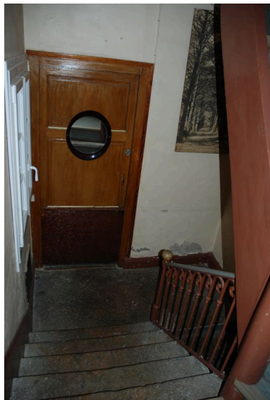
Vue du palier situé entre le rez- de-chaussée et le premier étage. Phot. Catherine Guillot IVR82_20116903093NUCA
