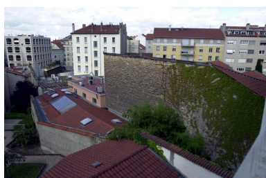
Elévation postérieure Phot. Maryannick Chalabi IVR82_20076902041NUCA
