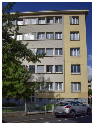
Façade sur la rue de Vallières Phot. Félicie Fougère IVR84_20256302095NUCA
