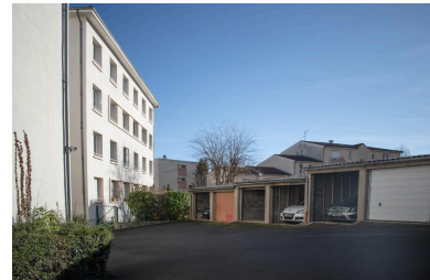
Immeubles et garages en fond de lotissement Phot. Félicie Fougère IVR84_20256302490NUCA
