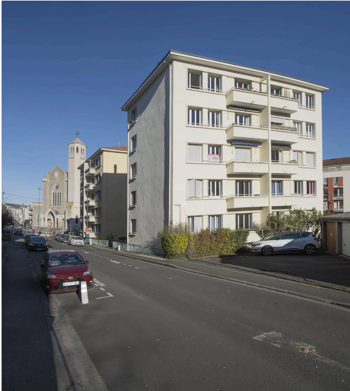
Immeubles du lotissement Bonhomme et Palazzi. A l'arrière-plan, l'église Sainte-Jeanne-d'Arc.
