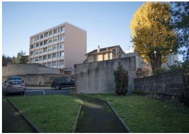
Garages et immeuble, vus depuis le fond de la parcelle du lotissement Bonhomme et Palazzi Phot. Félicie Fougère IVR84_20256302488NUCA
