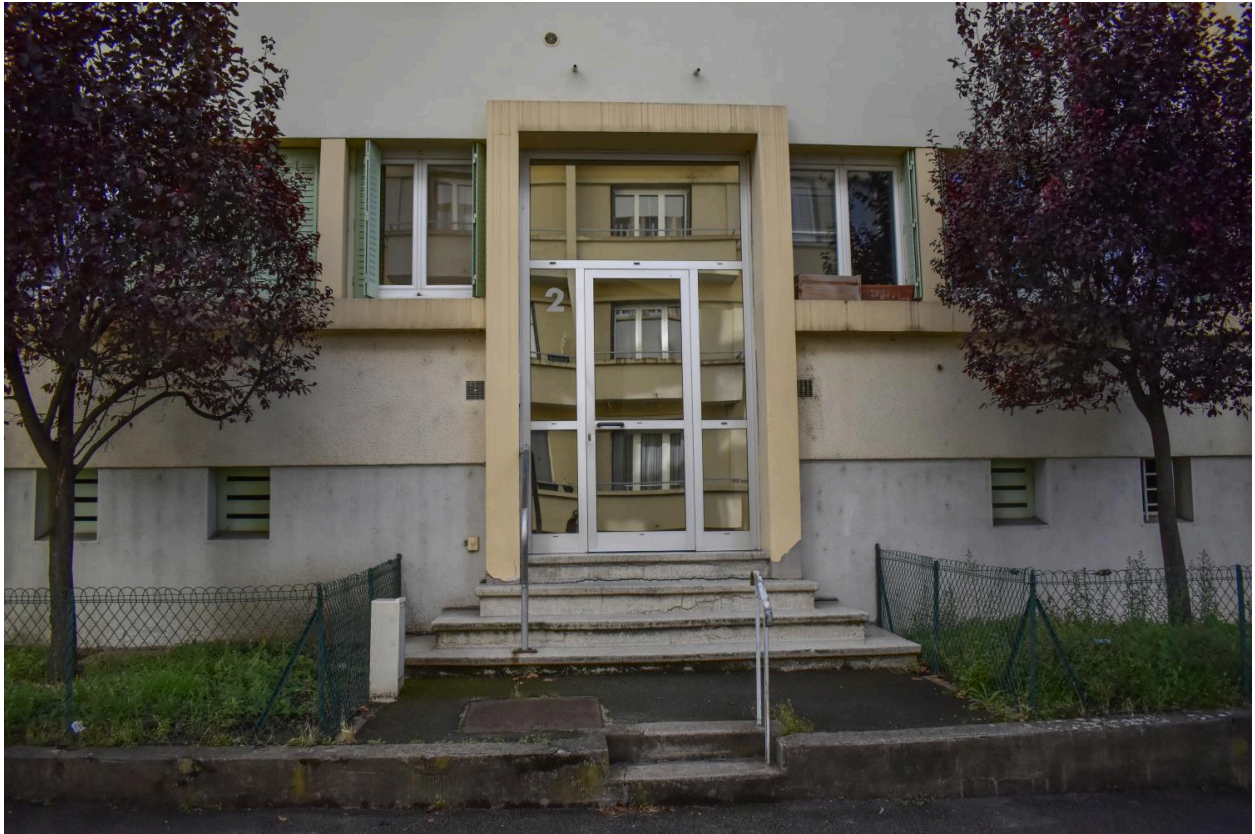
Détail d'architecture : entrée
