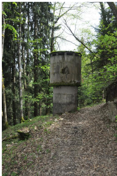
Cheminée d'équilibre. Phot. Clara Bérelle IVR82_20147302859NUCA
