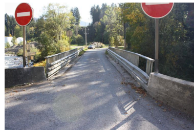
Le pont de la Lappiaz, chaussée et gardes corps Phot. Benoît Huraut IVR84_20207401080NUCA
