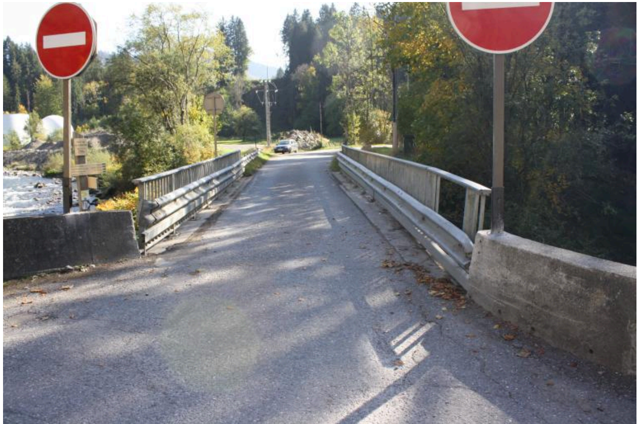
Le pont de la Lappiaz, chaussée et gardes corps
