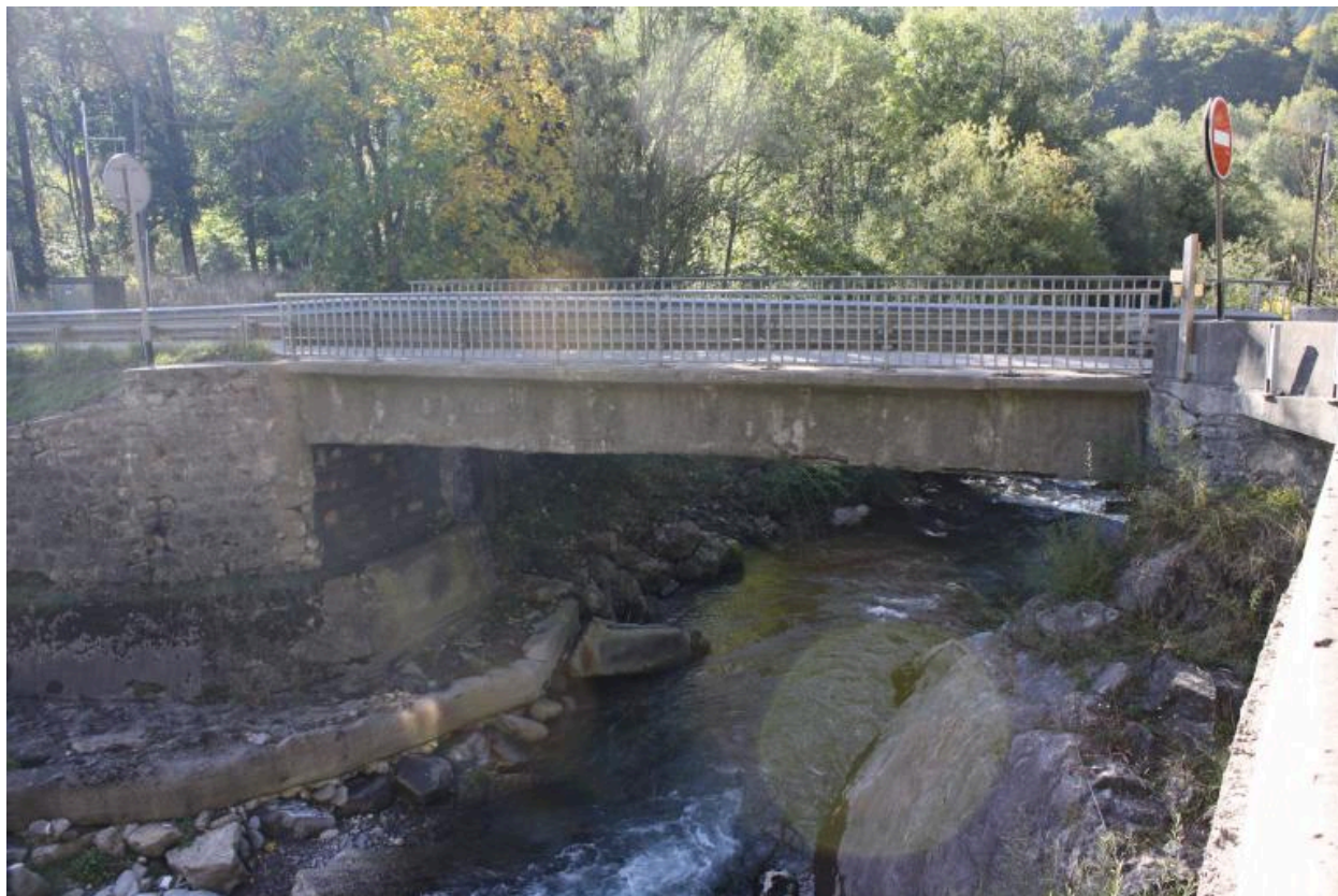
Pont de la Lappiaz, face amont
