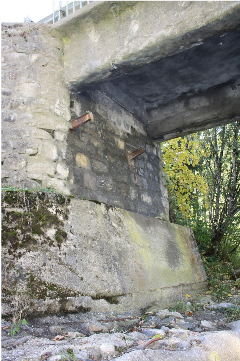
Le pont de la Lappiaz, détail culée rive gauche
