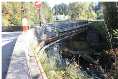
Pont de la Lappiaz, face aval Phot. Benoît Huraut IVR84_20207401079NUCA
