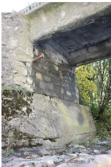
Le pont de la Lappiaz, détail culée rive gauche Phot. Benoît Huraut IVR84_20207401082NUCA
