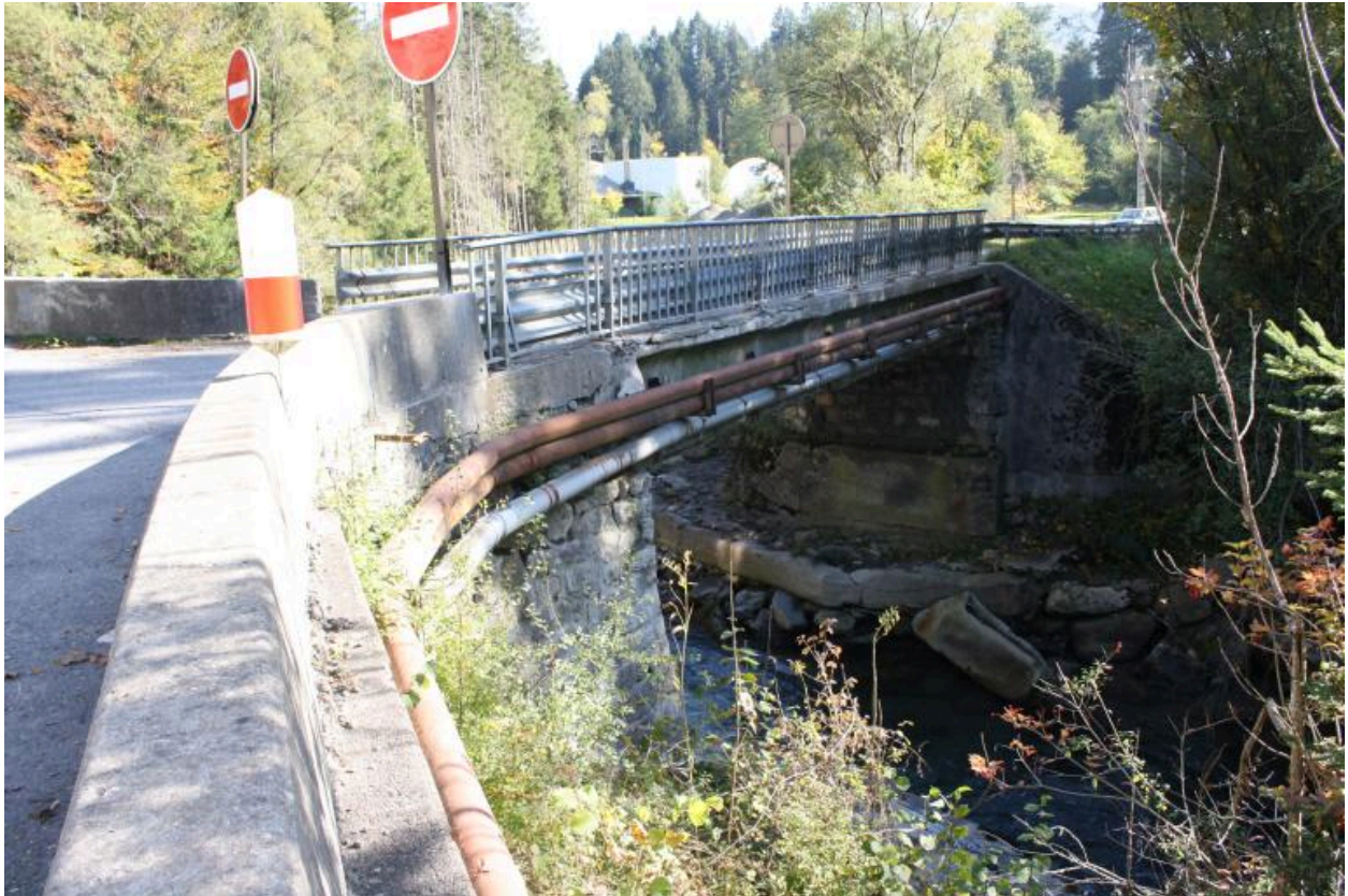
Pont de la Lappiaz, face aval
