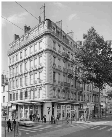
Vue générale depuis le sud-est Phot. Didier Gourbin IVR82_20066902151V
