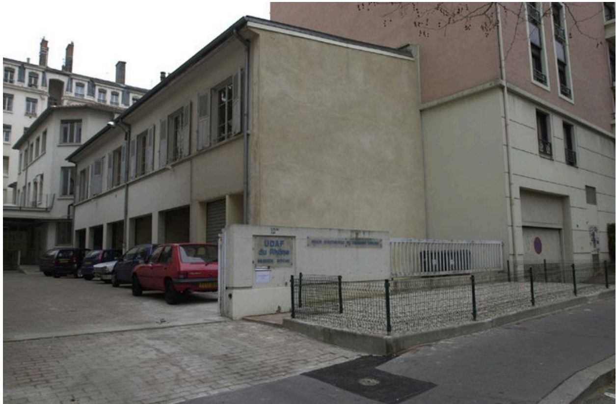
Vue générale depuis la rue (avec AD 88)
