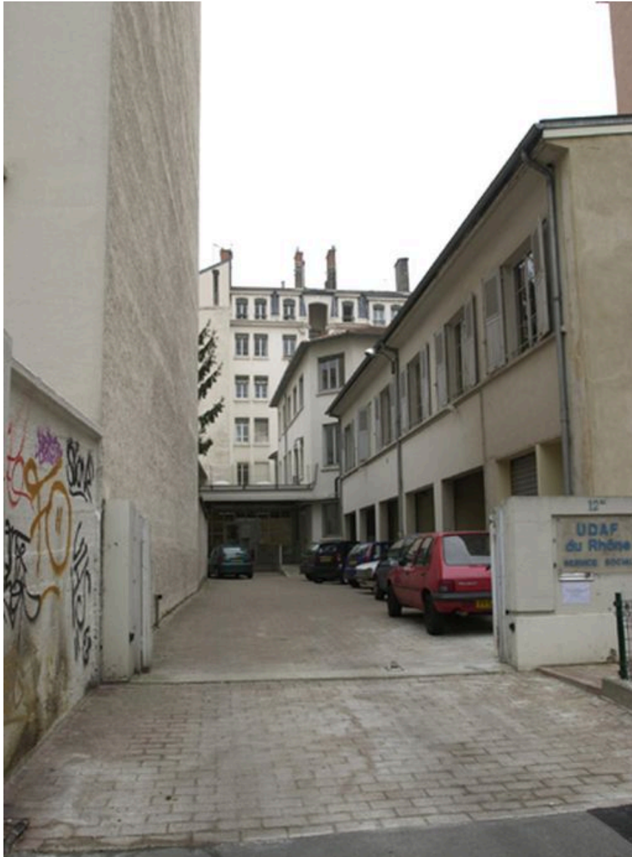
Vue générale depuis la rue (sans AD 88)
