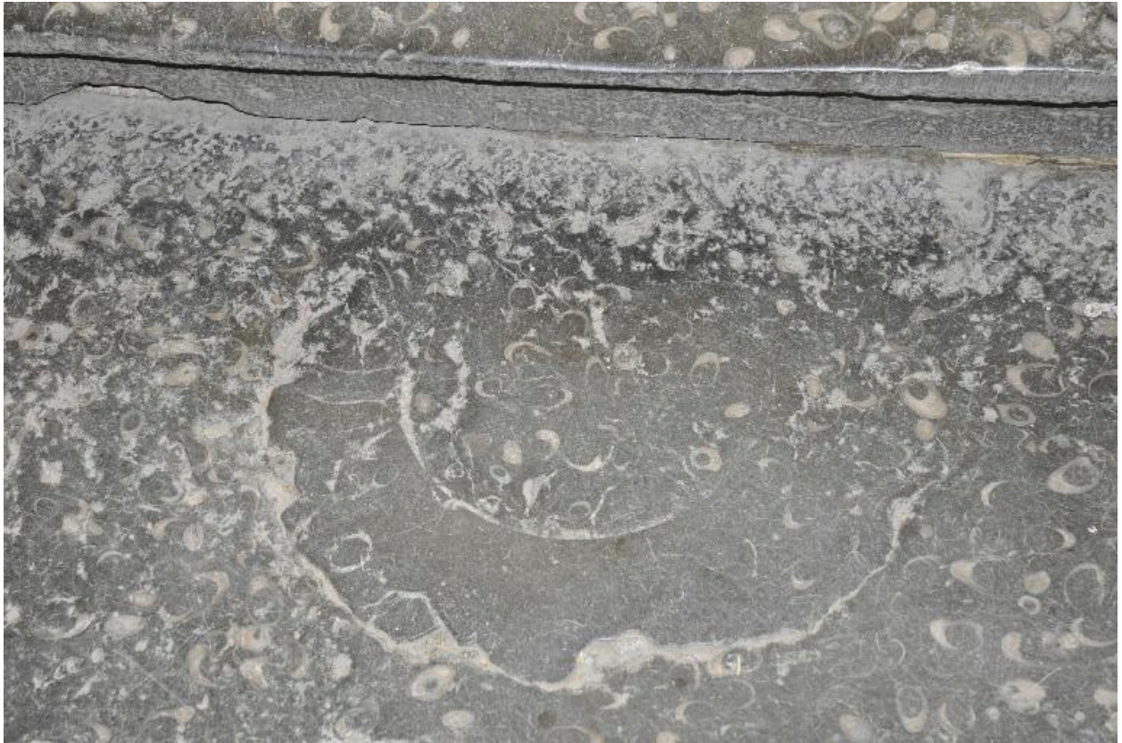
Détail de l'escalier avec un fossile d'ammonite
