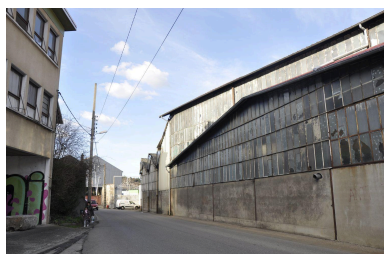
Vue de la façade sur rue Phot. Nadine Halitim-Dubois IVR82_20154200261NUCA
