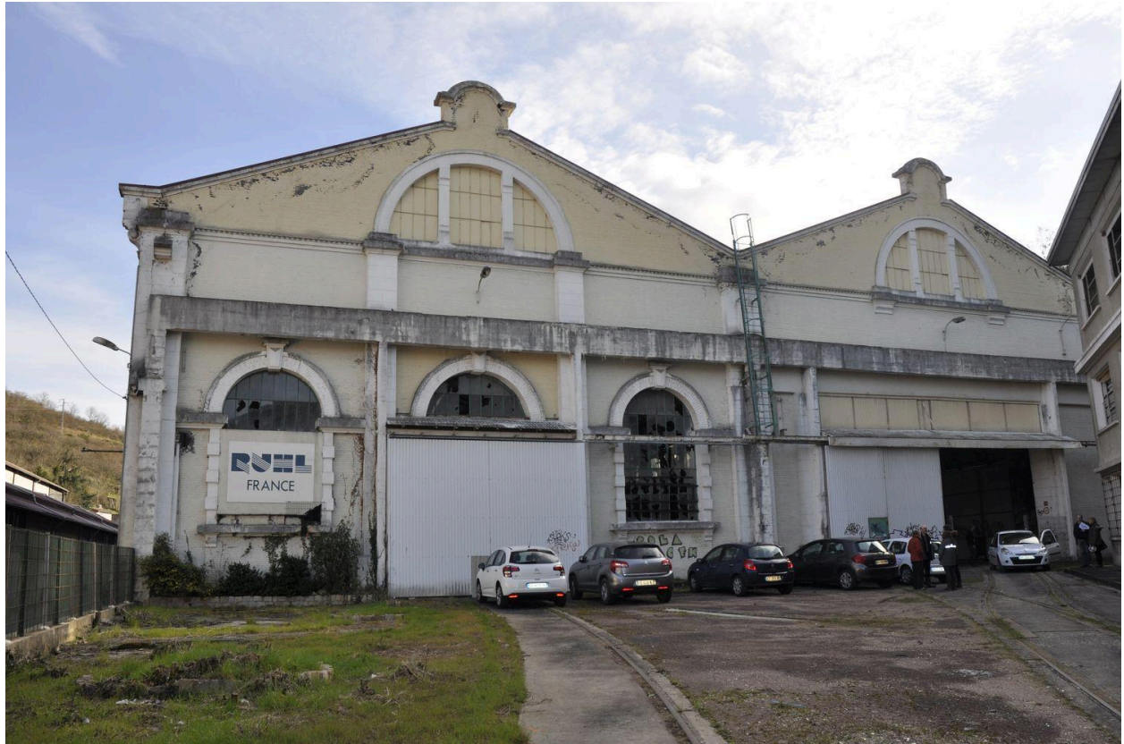
Double pignons entrée principale
