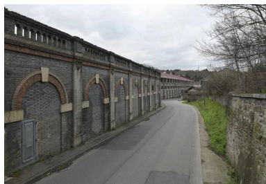
Vue d'ensemble de la façade des grandes halles de Couzon
