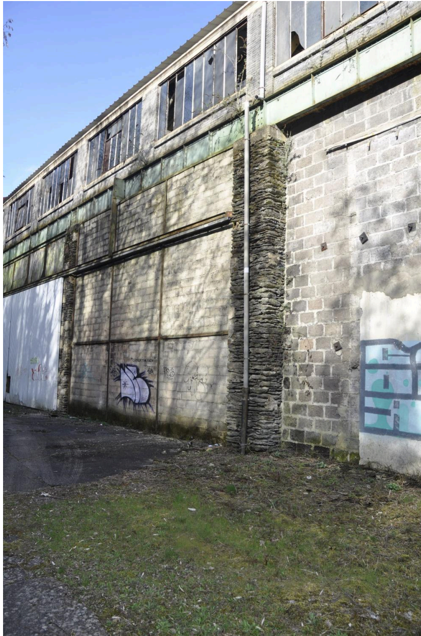
Détail matériaux de construction
