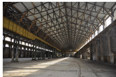
Vue d'ensemble du grand système de charpente
