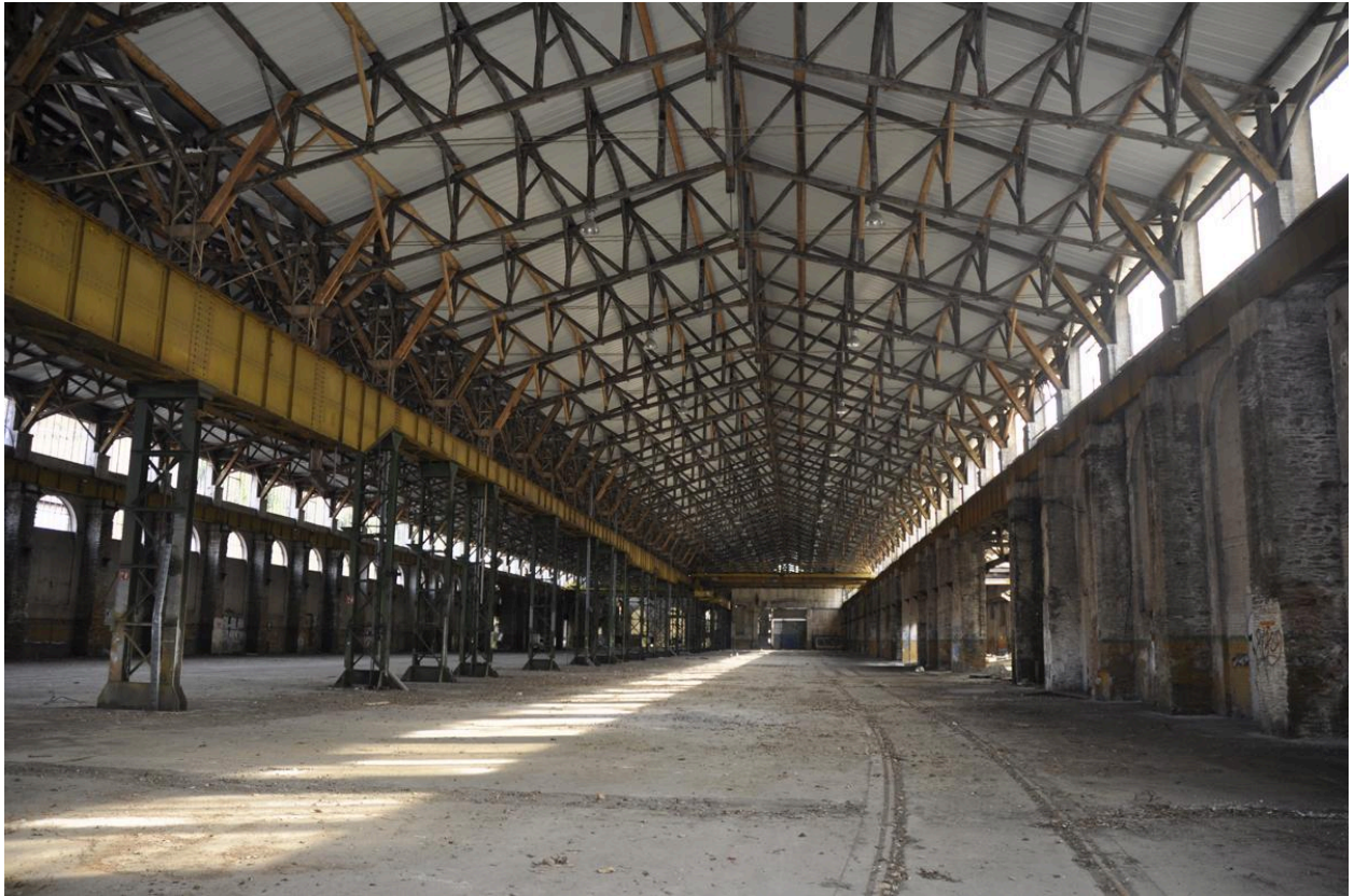
Vue d'ensemble du grand système de charpente
