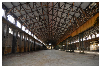
Détail charpente en bois
