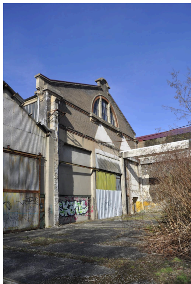
Pignon extérieur Phot. Nadine Halitim-Dubois IVR82_20154200244NUCA
