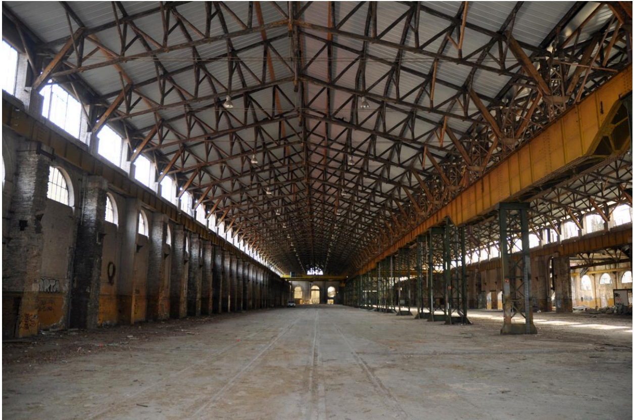
Détail charpente en bois
