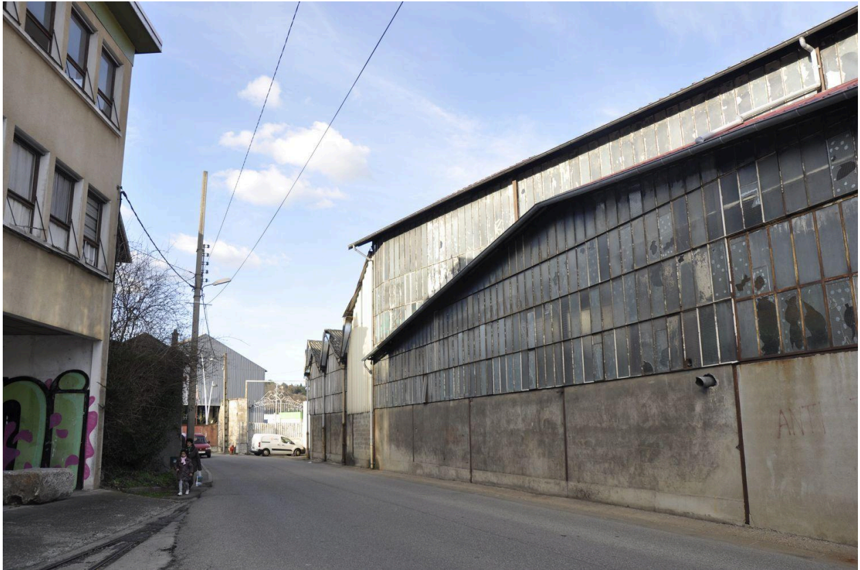
Vue de la façade sur rue
