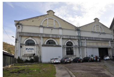
Double pignons entrée principale Phot. Nadine Halitim-Dubois IVR82_20154200260NUCA
