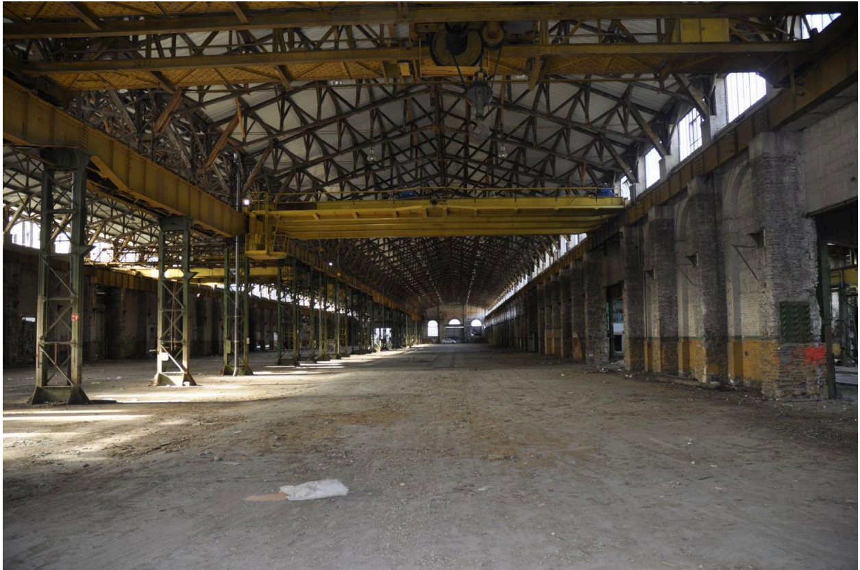
Vue d'ensemble des ponts roulants dans la grande halle
