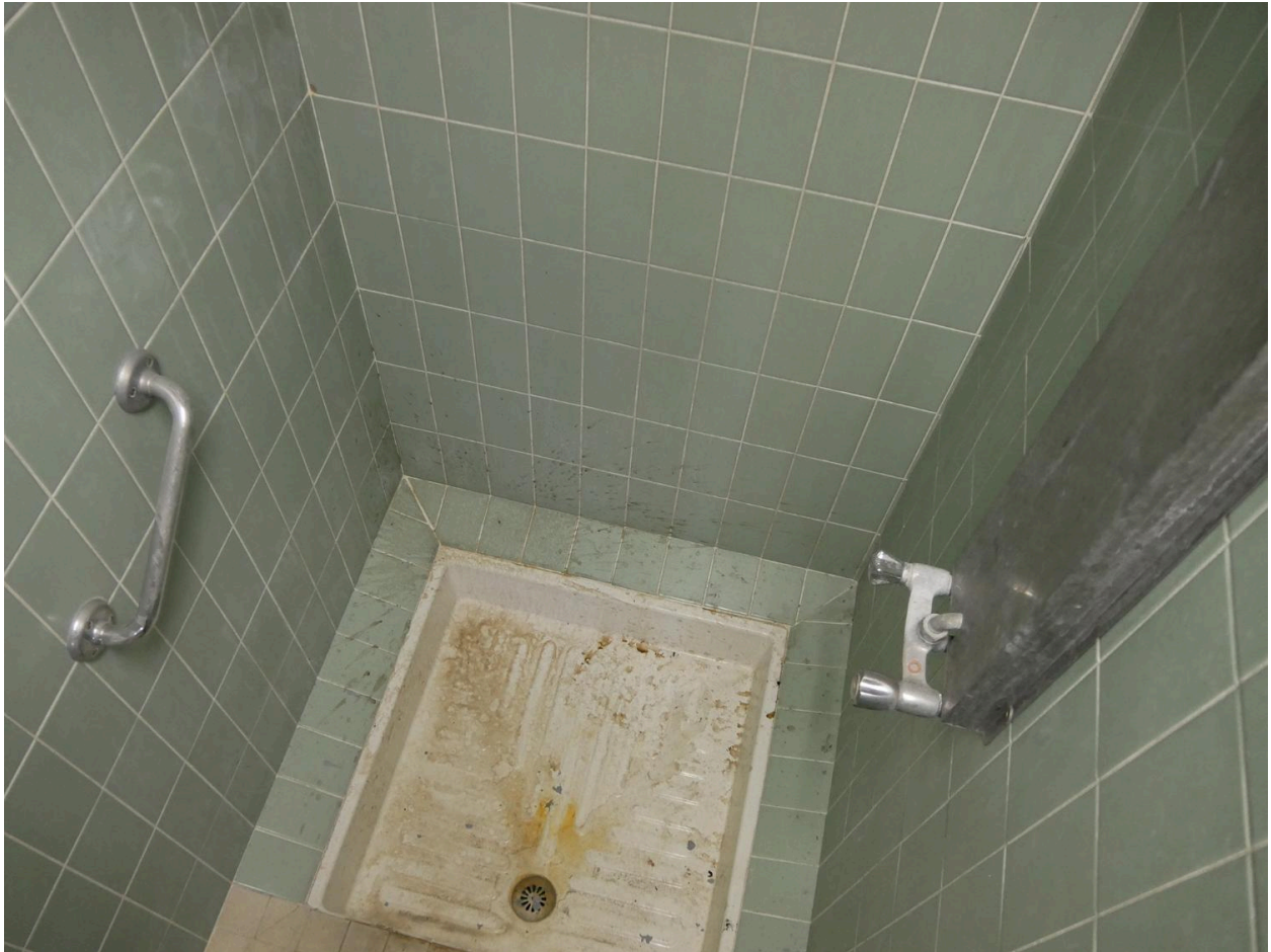
Détail cabine douche
