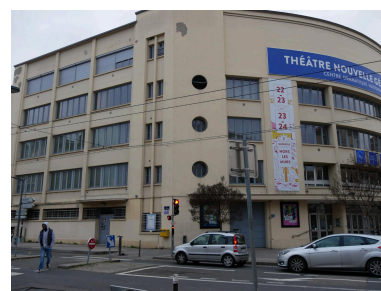
Baies oblongues en rez-de-chaussée des bains-douches Bourgogne Phot. Nadine Halitim-Dubois IVR84_20256902115NUCA
