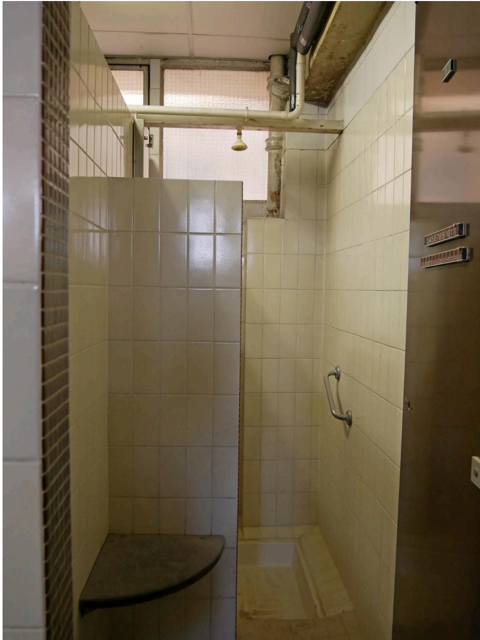
Détail cabine de douche
