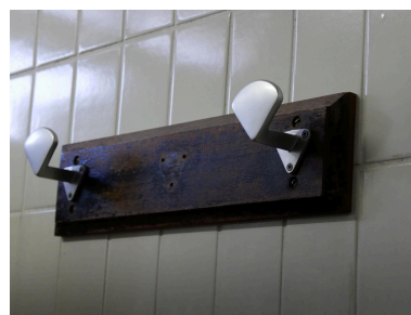
Détail cabine bains- douches Bourgogne-Vaise Phot. Nadine Halitim-Dubois IVR84_20256902108NUCA
