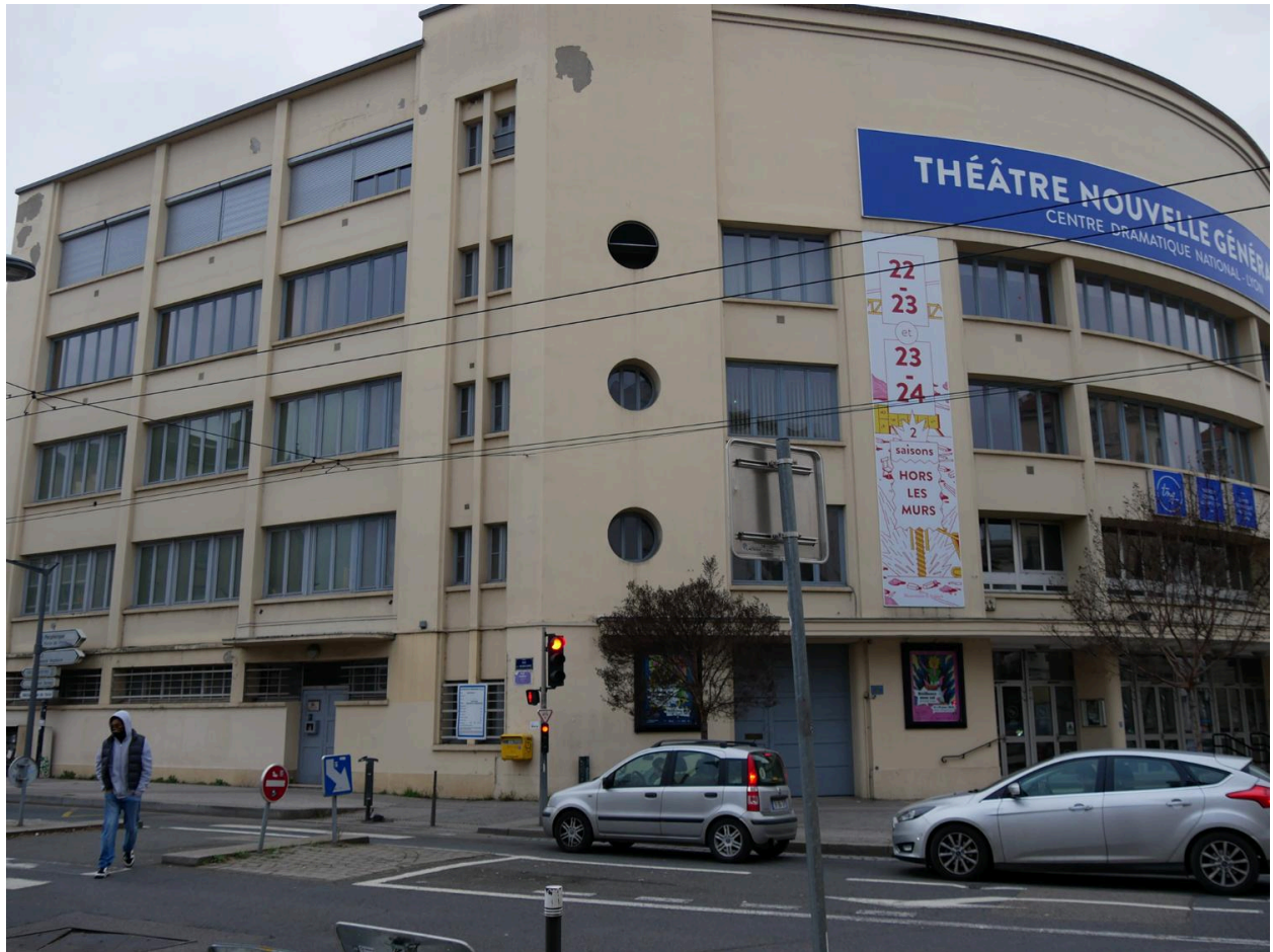
Baies oblongues en rez-de-chaussée des bains-douches Bourgogne
