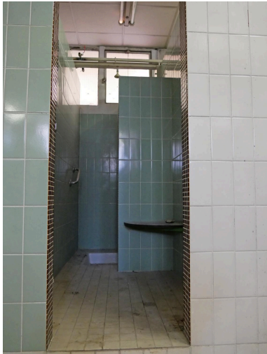
Cabine douche Phot. Nadine Halitim-Dubois IVR84_20256902090NUCA
