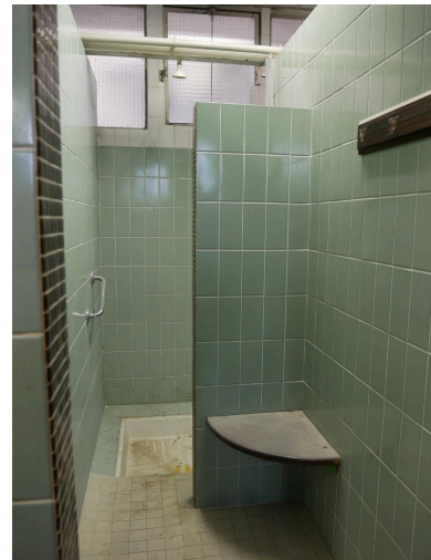
Cabine douche Phot. Nadine Halitim-Dubois IVR84_20256902098NUCA
