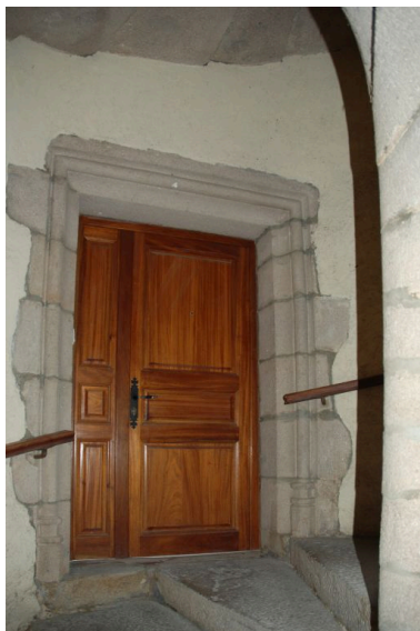
Porte palière du 1er étage. Phot. Simone Hartmann-Nussbaum IVR82_20124202589NUCA
