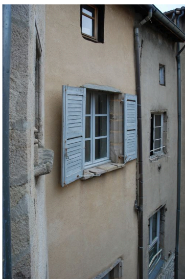
Vue partielle de l'aile gauche depuis la galerie du 2e étage. Phot. Simone Hartmann-Nussbaum IVR82_20124202593NUCA
