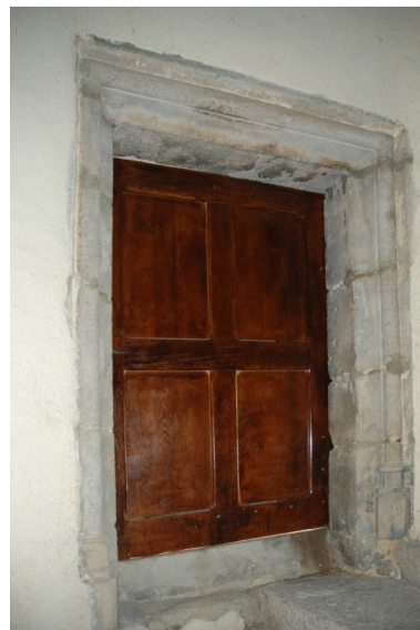
Porte palière du 2e étage. Phot. Simone Hartmann-Nussbaum IVR82_20124202590NUCA
