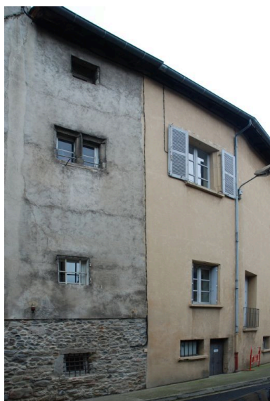
Vue partielle de l'élévation latérale donnant sur la rue Pasteur. Phot. Simone Hartmann-Nussbaum IVR82_20124202595NUCA
