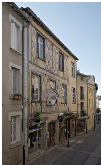
Vue de situation sur rue de trois-quarts gauche. Phot. Eric Dessert IVR82_20064200668NUCA
