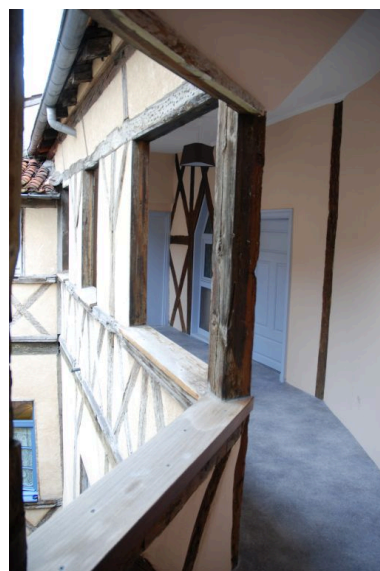
Vue de la galerie du 2e étage. Phot. Simone Hartmann-Nussbaum IVR82_20124202591NUCA
