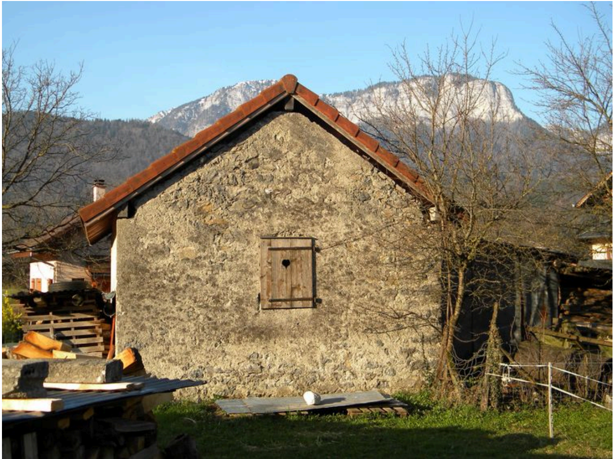
Vue de la façade arrière.
