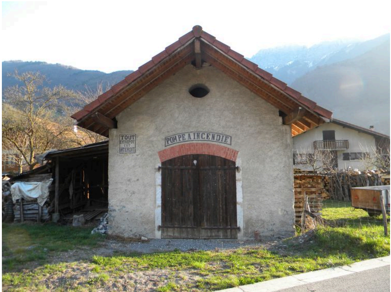
Vue générale du pignon en façade pincipale.
