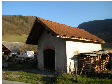
Vue de trois-quarts depuis la façade est. Phot. Jérôme Daviet IVR82_20127400808NUCA
