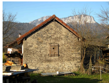
Vue de la façade arrière. Phot. Jérôme Daviet IVR82_20127400810NUCA
