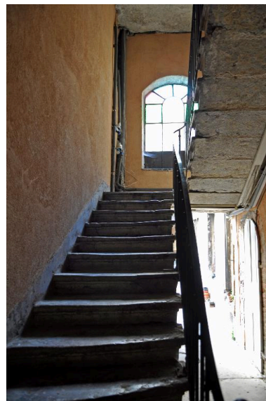
Vue intérieure : l'escalier Phot. Catherine Guégan IVR84_20176901361NUCA
