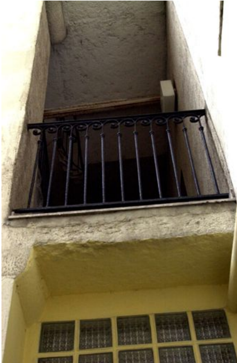
Détail de la cage d'escalier ouverte et de son garde-corps
