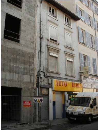
façade ouest Phot. Benoît Chapelle IVR82_20073800069NUCA
