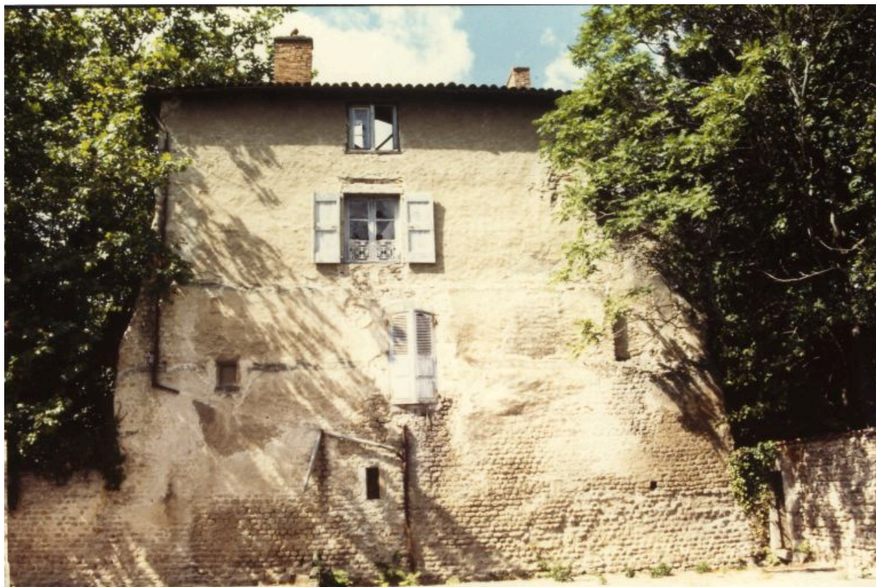
Elévation est de la maison avec appareillages anciens. Photographie monument historique, vers 1987.
