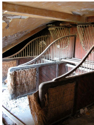
Vue partielle des boxs à chevaux de l'écurie de la maison. Phot. Thierry Monnet IVR82_20134203307NUCA
