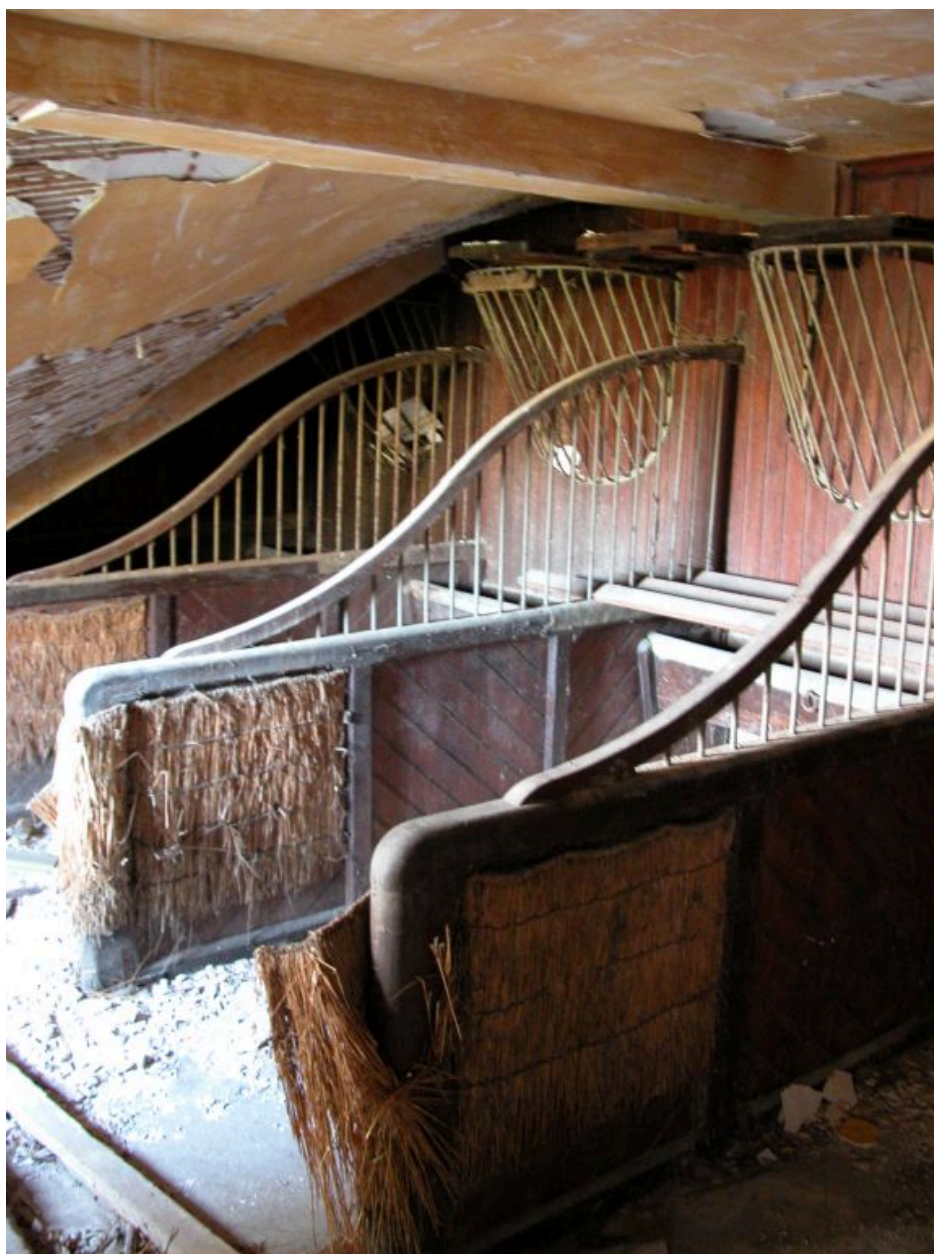
Vue partielle des boxs à chevaux de l'écurie de la maison.
