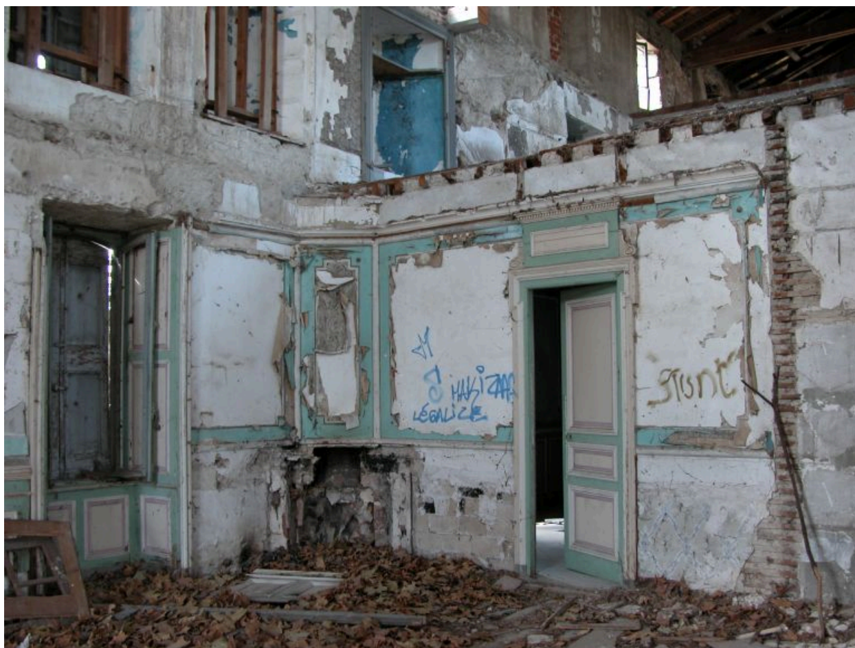
Vue partielle intérieure du rez-de-chaussée surélevé de la maison.
