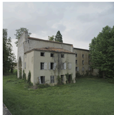
Vue d'ensemble latérale droite partielle des bâtiments du site de Sainte-Eugénie. Phot. Eric Dessert IVR82_20084200974NUCA
