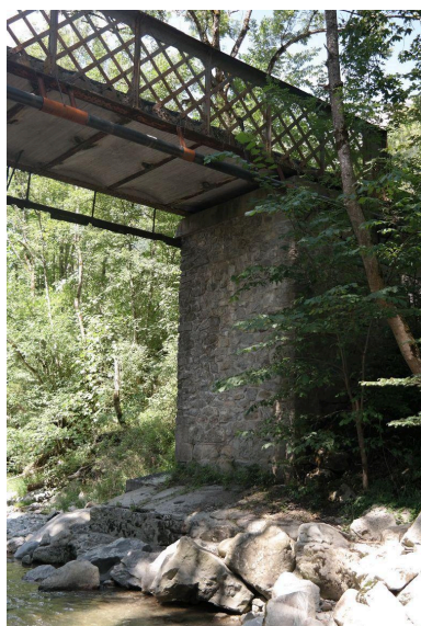
Passerelle de Sous-le-Pas culée rive droite Phot. Pascale Renard IVR84_20197401243NUCA
