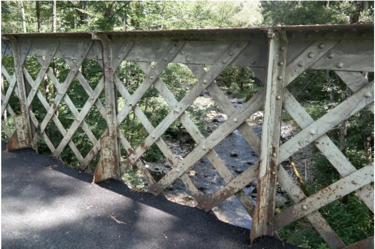
Passerelle de Sous-le-Pas, détail rambarde métallique
