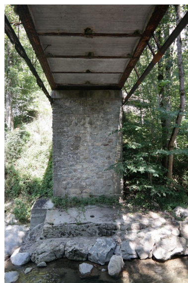
Passerelle de Sous-le-Pas vue du dessous Phot. Pascale Renard IVR84_20197401245NUCA
