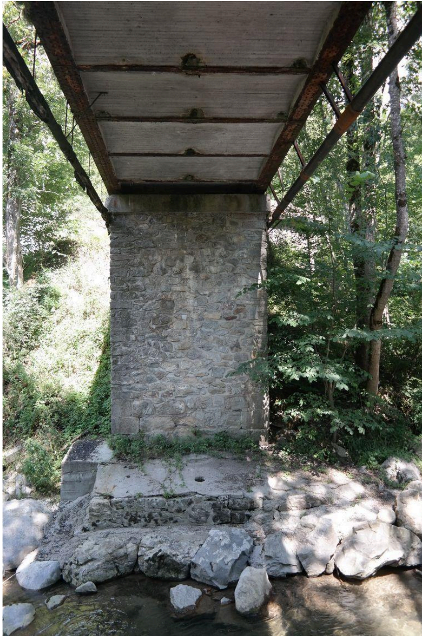
Passerelle de Sous-le-Pas vue du dessous
