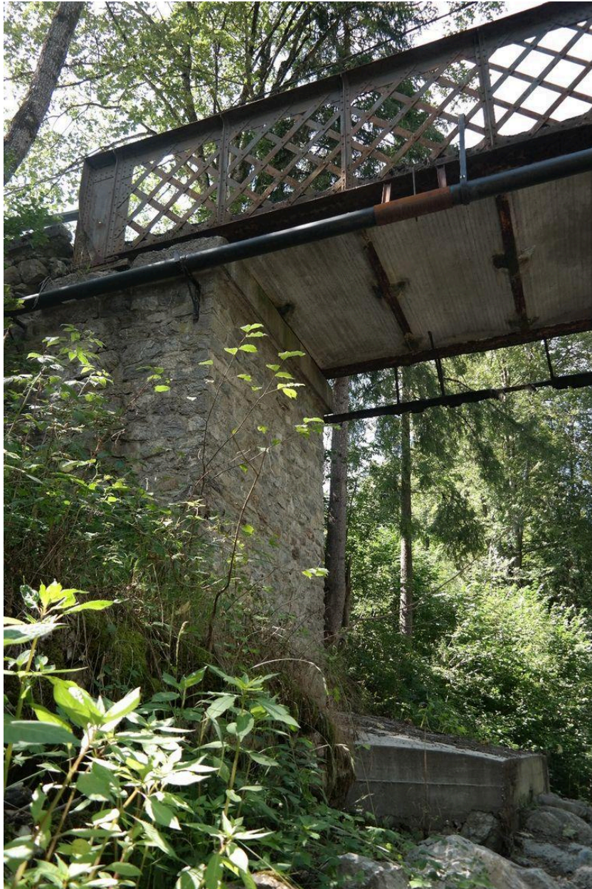
Passerelle de Sous-le-Pas culée rive gauche
