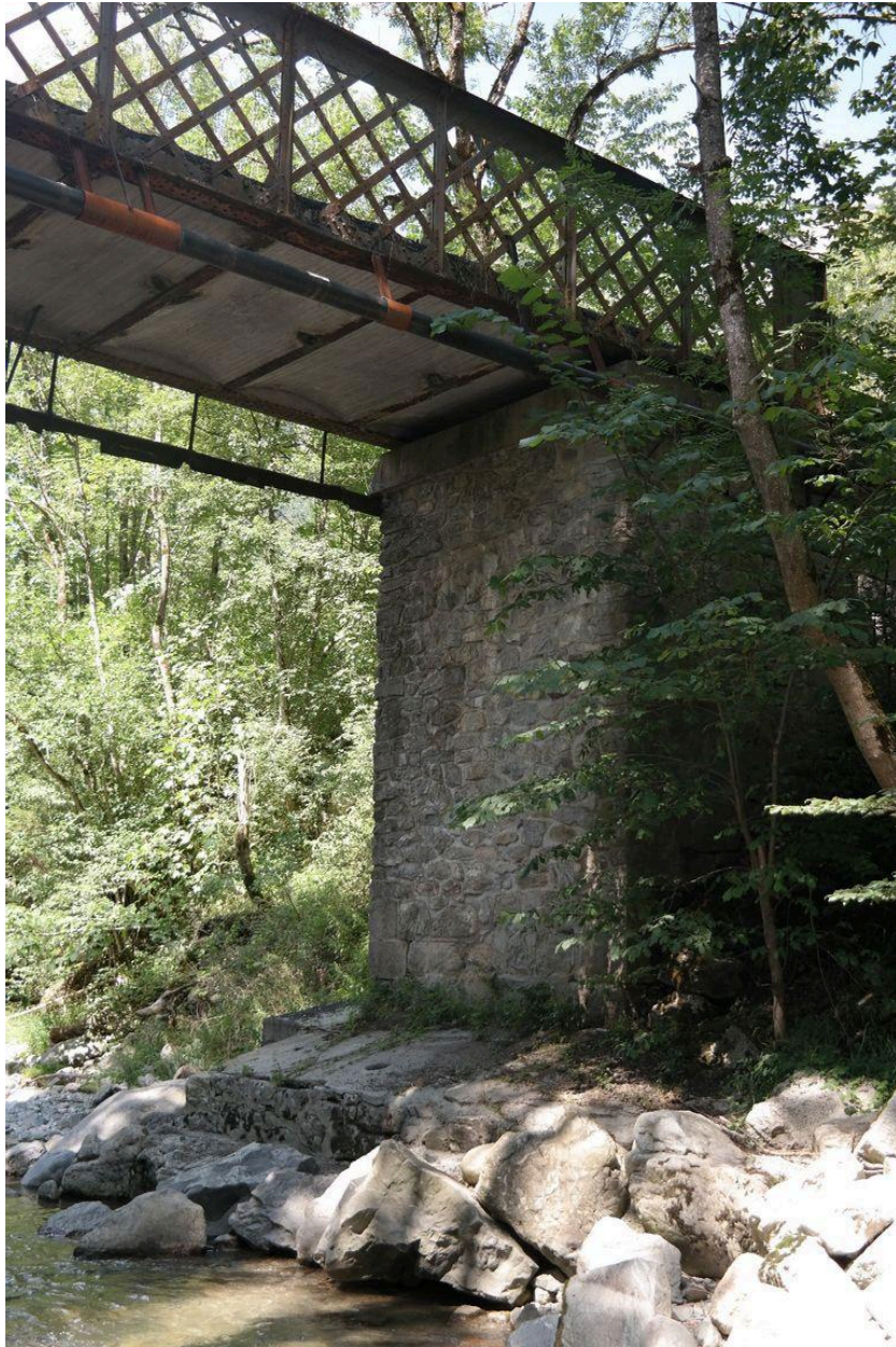
Passerelle de Sous-le-Pas culée rive droite
