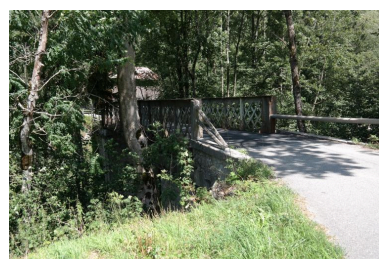
Passerelle de Sous-le-Pas vue depuis la rive gauche Phot. Pascale Renard IVR84_20197401242NUCA
