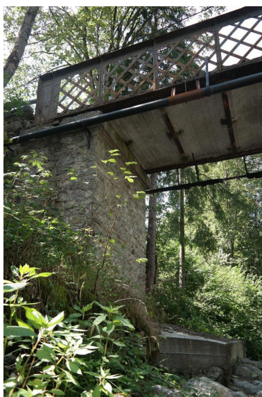
Passerelle de Sous-le-Pas culée rive gauche Phot. Pascale Renard IVR84_20197401244NUCA
