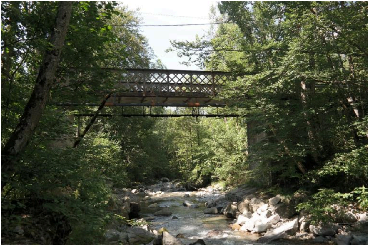
Vue générale de la passerelle de Sous le Pas
