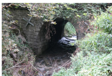
POnt du Chef-Lieu de Vacheresse, face aval détail de la voûte et du lit du court d'eau Phot. Pascale Renard IVR84_20207401227NUCA
