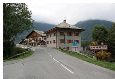
Pont du Chef-Lieu de Vacheresse et son environnement Phot. Pascale Renard IVR84_20207401229NUCA
