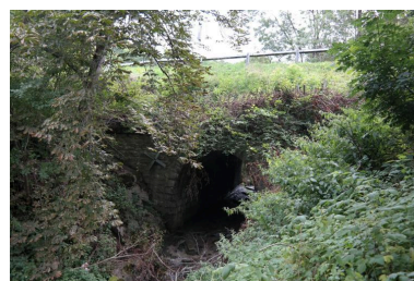
POnt du Chef-Lieu de Vacheresse, vue de la face aval Phot. Pascale Renard IVR84_20207401226NUCA
