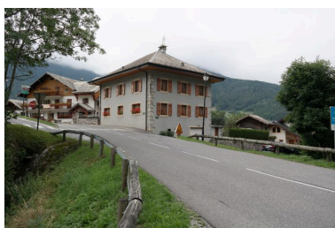
Vue générale du pont du Chef-Lieu Phot. Pascale Renard IVR84_20197401215NUCA
