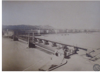
[Construction du Pont du Midi sur le Rhône : l'ancien pont suspendu et la passerelle provisoire]. [1887]. 1 fotogr. pos. : n. et b. (AM Lyon.2 Ph 00278, n°1) Phot. F. Bardoneschi, Autr. Ernest- David (ingénieur) Fabrègue, Autr. J.-E. (photographe) Tardy IVR82_20106902790NUCAB
