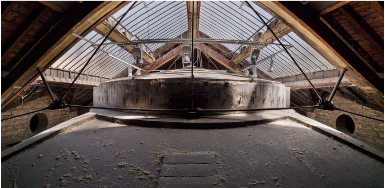
Combles : éclairage zénithal de la coupole.
