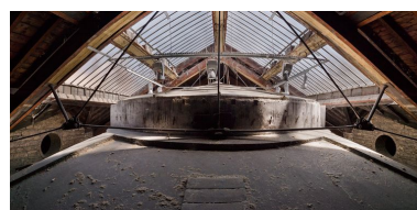
Comble : éclairage zénithal de la coupole. Phot. Eric Dessert
