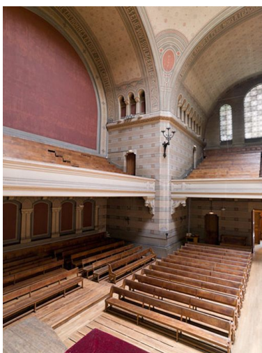
Pilier supportant la voûte, angle de la tribune centrale et de la tribune sud. Phot. Eric Dessert IVR82_20106902406NUCA
