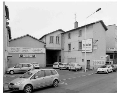
Vue des bâtiments en alignement sur la rue Croix-Barret Phot. Didier Gourbin IVR82_20066900074X
