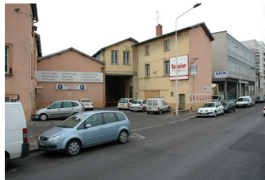
Vue d'ensemble nord-est Phot. Didier Gourbin IVR82_20056902973NUCA
