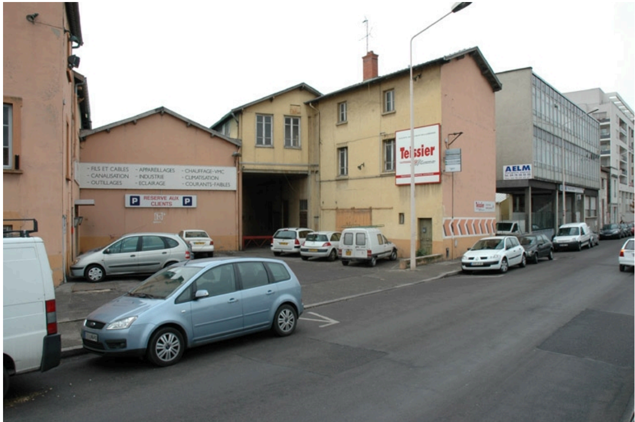
Vue d'ensemble nord-est
