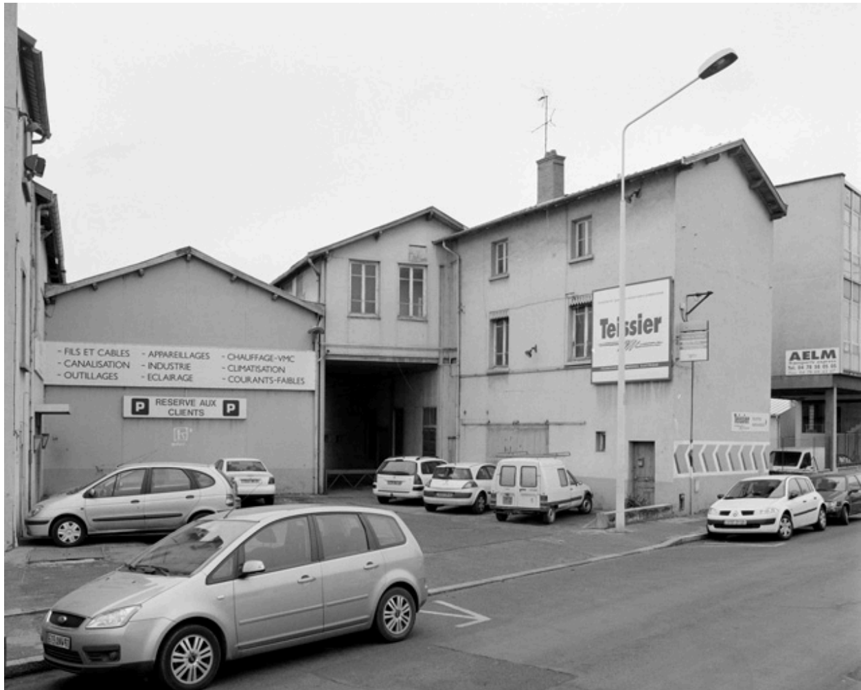
Vue des bâtiments en alignement sur la rue Croix-Barret
