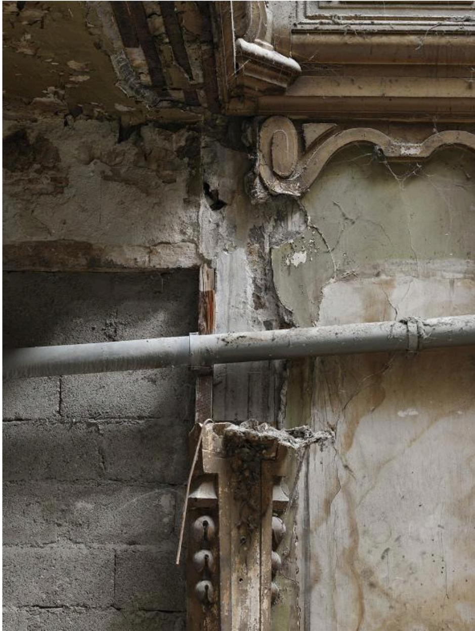
Cour, dégradations : tuyau passant à travers une console
