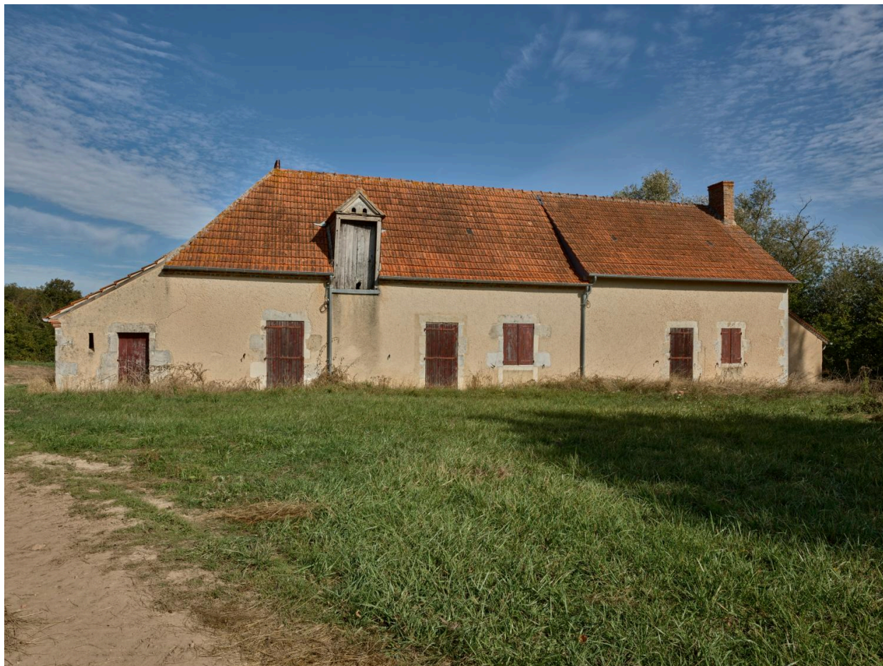
Vue générale de la façade méridionale.
