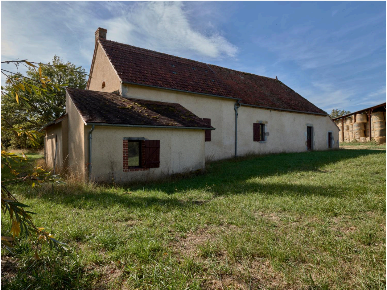
Vue de la façade nord.
