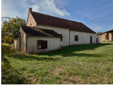
Vue de la façade nord. Phot. Christian Parisey IVR84_20230300408NUC4A
