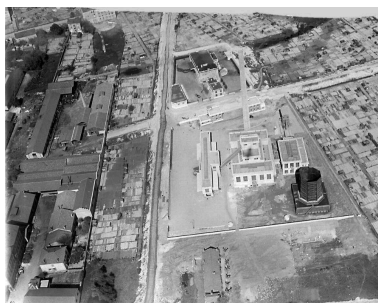
Usine de traitement des ordures ménagères 1929-1932 (AC Lyon 15PH/1/190) Phot. Nadine Halitim-Dubois IVR84_20186901455NUC
