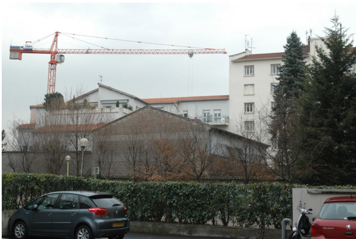
Entrepôt vitrerie, vue générale sud ouest
