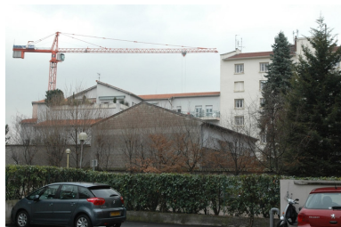
Entrepôt vitrerie, vue générale sud ouest Phot. Nadine Halitim-Dubois IVR82_20096901730NUCA
