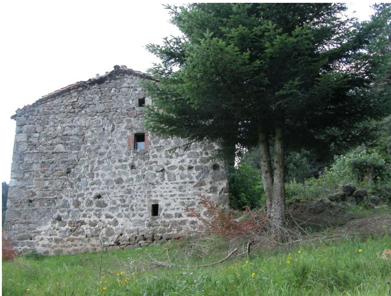
Vue d'ensemble du mur pignon nord.
