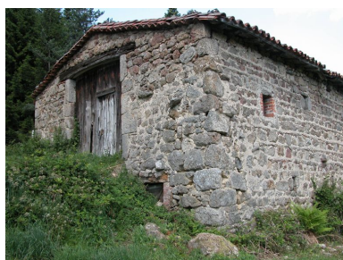
Vue partielle de trois quarts sud-est. Phot. Thierry Monnet IVR82_20134200134NUCA
