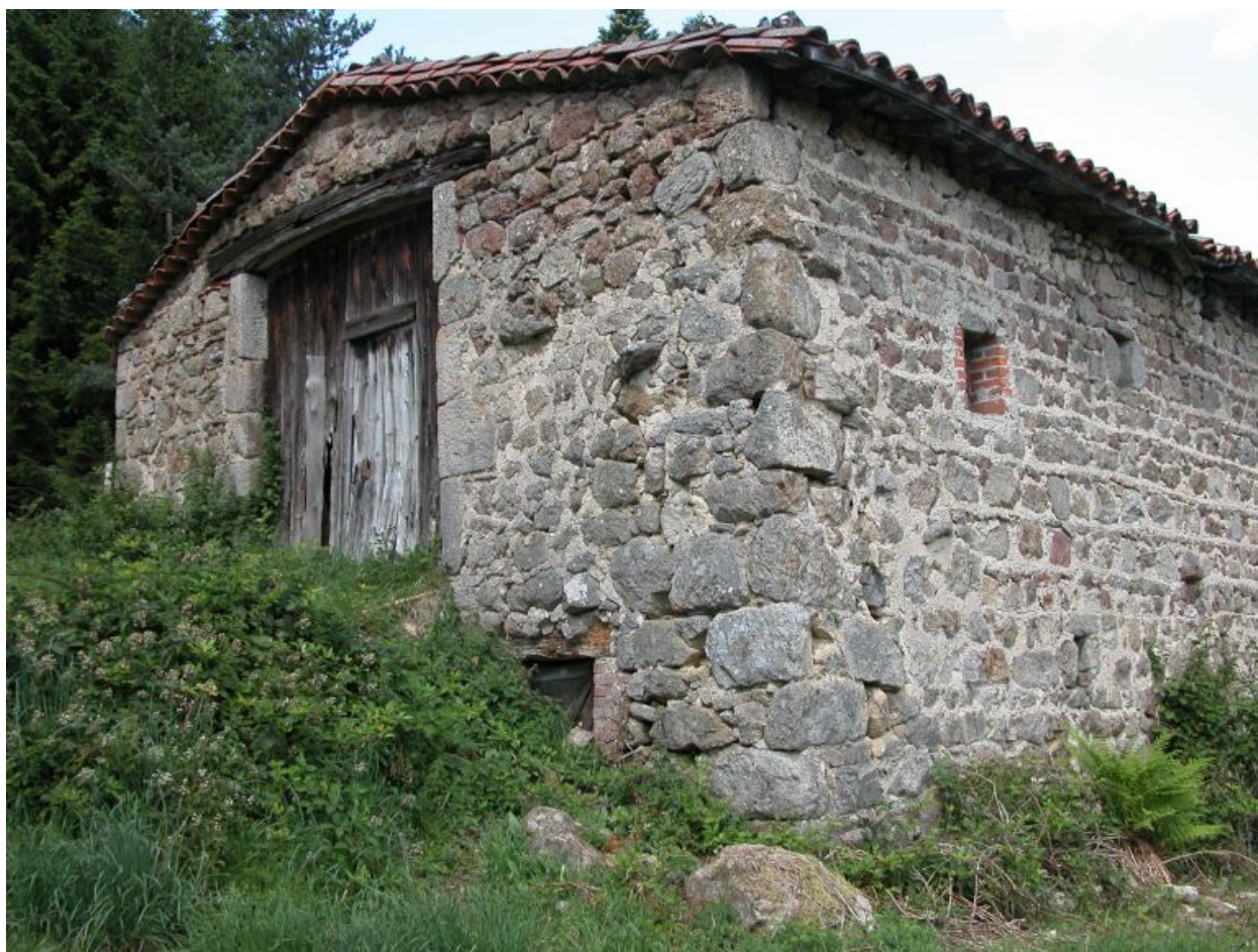
Vue partielle de trois quarts sud-est.
