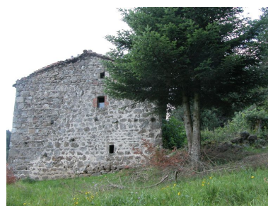
Vue d'ensemble du mur pignon nord. Phot. Thierry Monnet IVR82_20134200130NUCA
