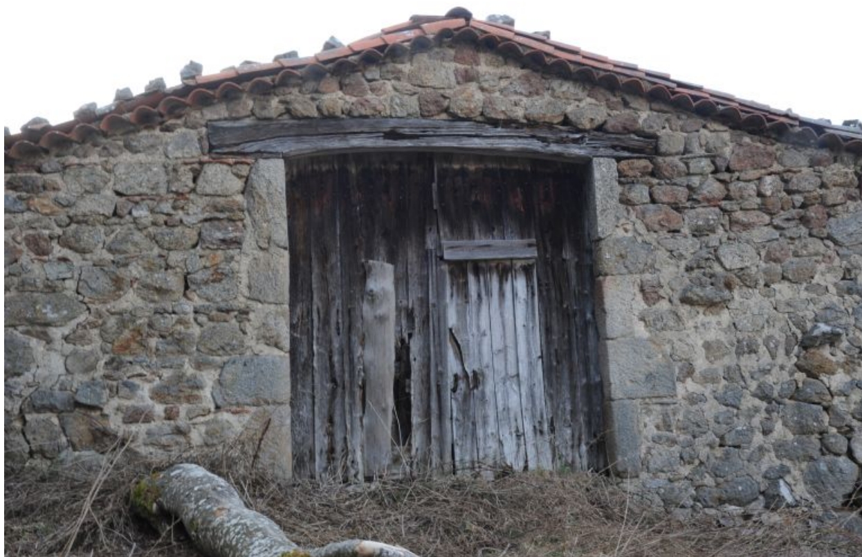
Mur pignon sud, vue d'ensemble.
