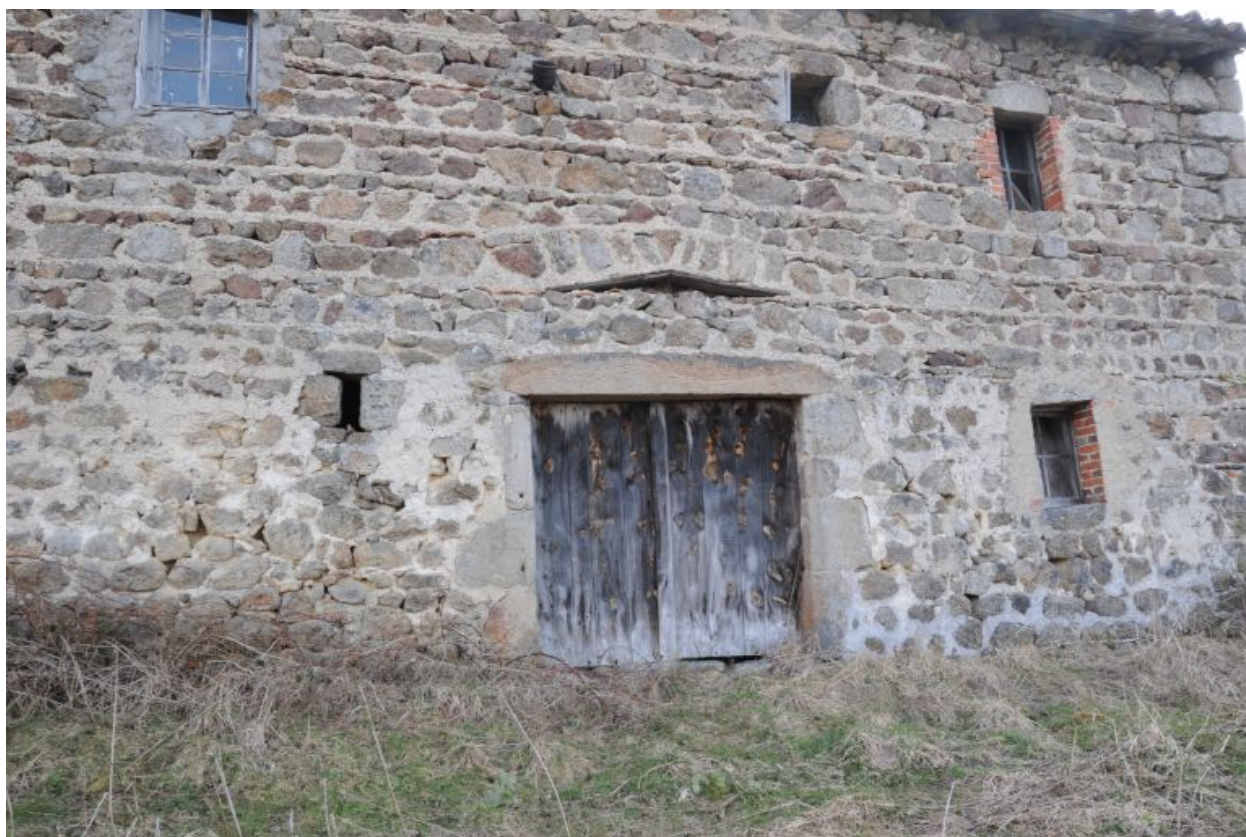
Mur pignon sud, détail des baies.
