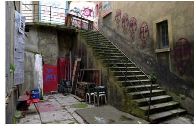
Corps n° 14, escalier dans la cour Phot. Bernard Ducouret IVR82_20016901426NUCA
