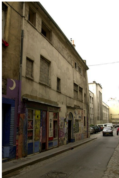
Corps n° 12, façade sur rue Phot. Bernard Ducouret IVR82_20016901418NUCA
