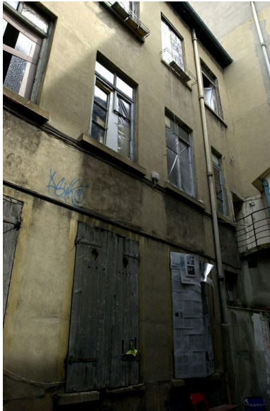
Corps du n° 14, façade sur cour Phot. Bernard Ducouret IVR82_20016901424NUCA
