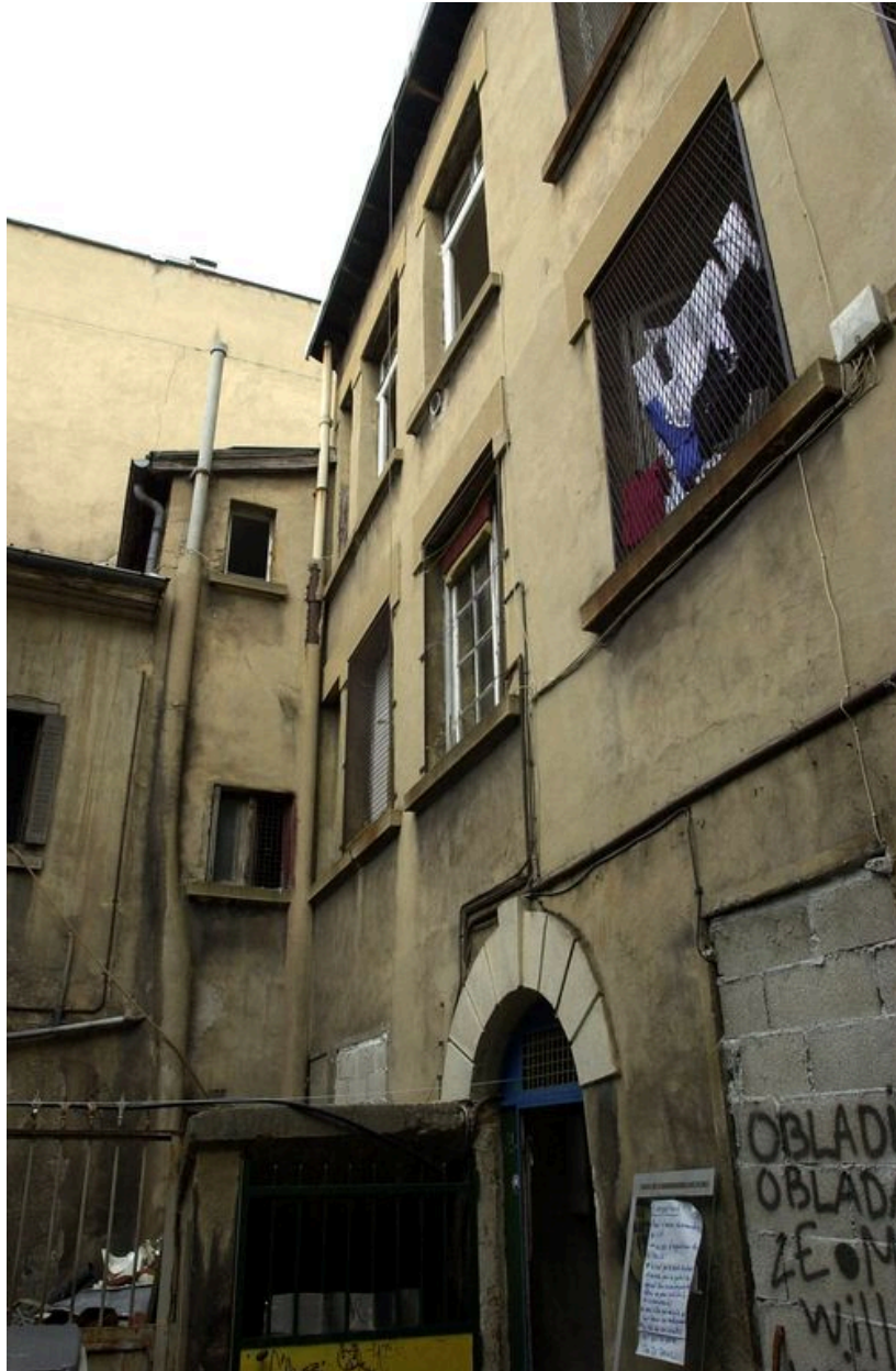
Corps du n° 12, façade sur cour, partie gauche
