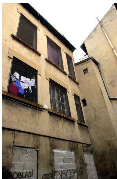
Corps du n° 12, façade sur cour, partie droite Phot. Bernard Ducouret IVR82_20016901421NUCA
