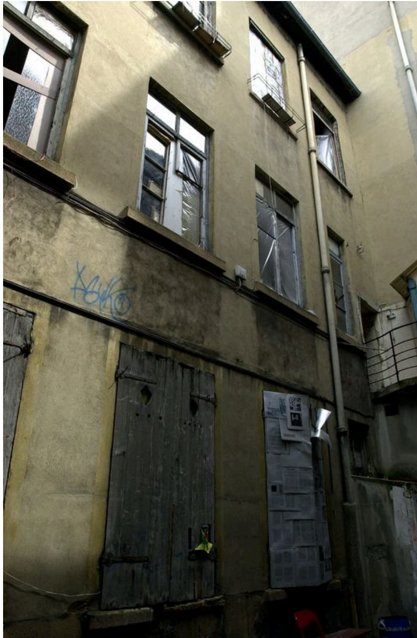
Corps du n° 14, façade sur cour
