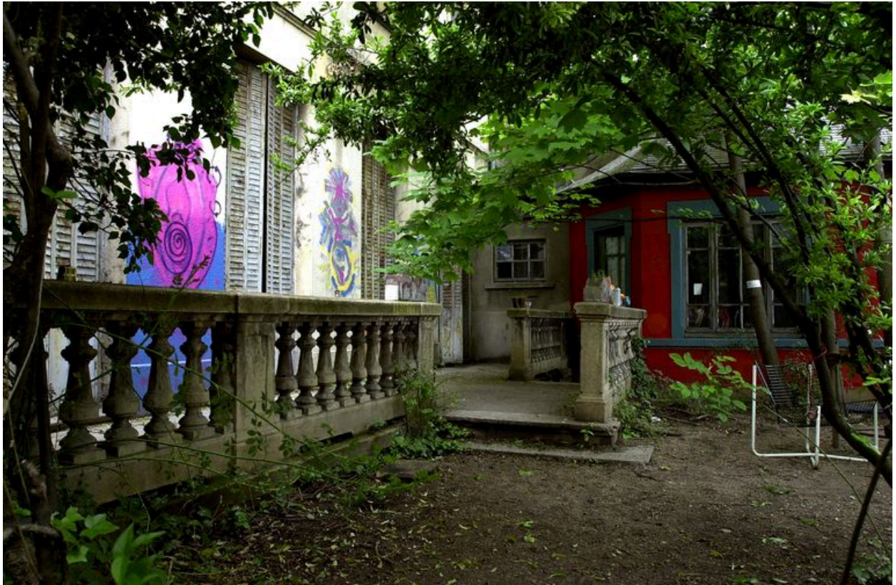
Deuxième corps du n° 14, façade sur jardin, détail du rez-de-chaussée
