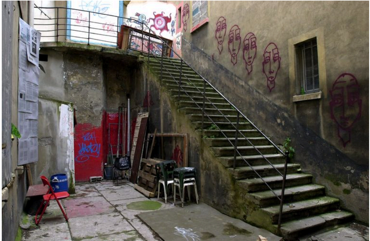
Corps n° 14, escalier dans la cour
