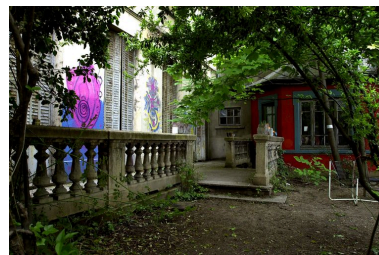
Deuxième corps du n° 14, façade sur jardin, détail du rez-de-chaussée Phot. Bernard Ducouret IVR82_20016901432NUCA
