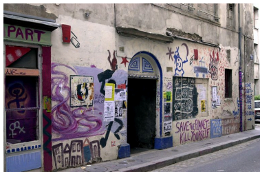
Corps n° 12, façade sur rue, détail du rez-de-chaussée Phot. Bernard Ducouret IVR82_20016901419NUCA
