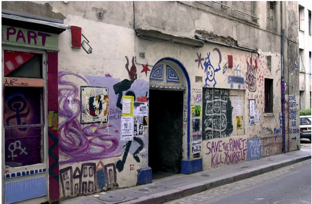
Corps n° 12, façade sur rue, détail du rez-de-chaussée
