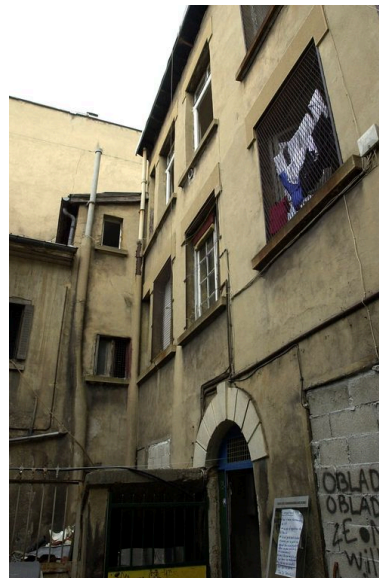
Corps du n° 12, façade sur cour, partie gauche Phot. Bernard Ducouret IVR82_20016901420NUCA
