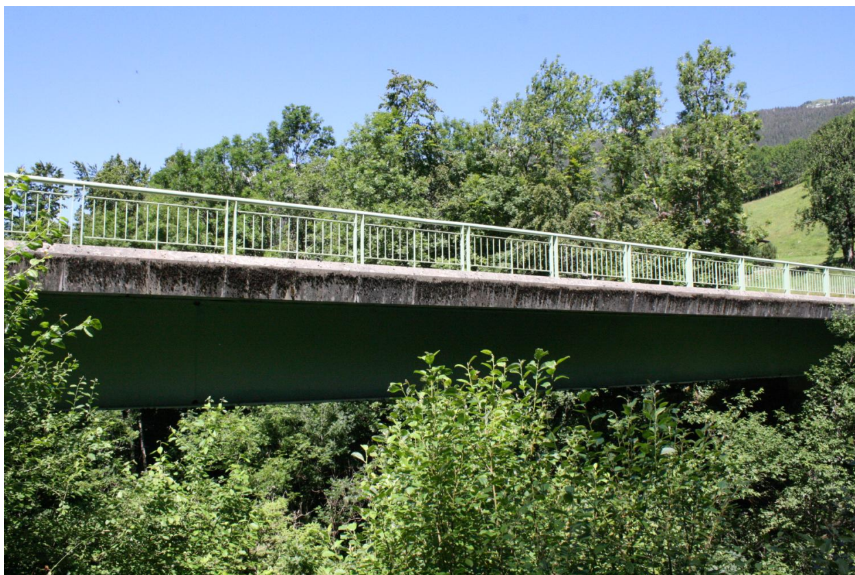
Grand pont de la scierie, face amont
