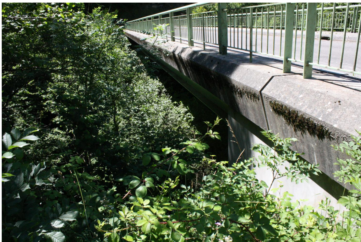
Grand pont de la scierie, face aval
