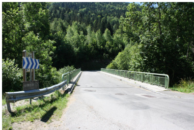
Grand pont de la scierie, chaussée et gardes corps Phot. Benoît Huraut IVR84_20207401669NUCA
