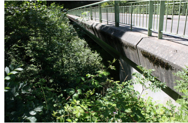
Grand pont de la scierie, face aval Phot. Benoît Huraut IVR84_20197402094NUCA
