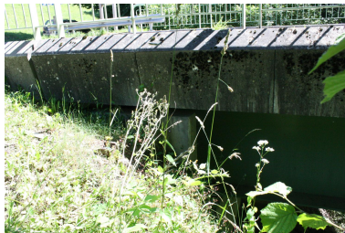
Grand pont de la scierie, détails culée et plinthe Phot. Benoît Huraut IVR84_20207401670NUCA
