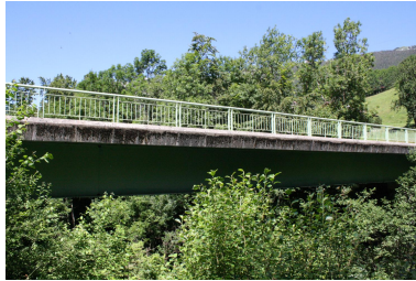
Grand pont de la scierie, face amont Phot. Benoît Huraut IVR84_20207401667NUCA
