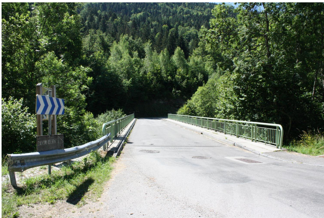
Grand pont de la scierie, chaussée et gardes corps
